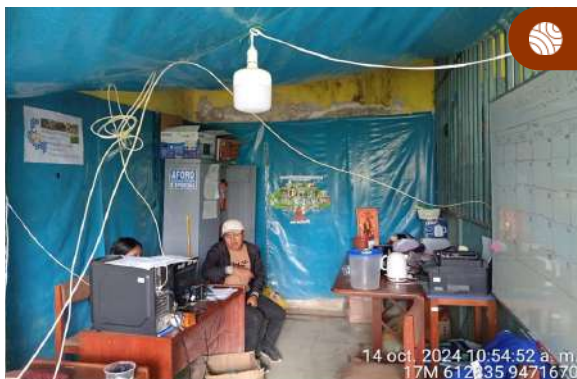
Figura 13. Las oficinas de la Municipalidad Distrital de Sapillica presentan paredes y techos humedecidos por la infiltración del agua que podría afectar equipos y la infraestructura física.
