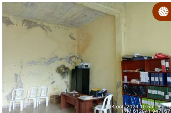
Figura 13. Las oficinas de la Municipalidad Distrital de Sapillica presentan paredes y techos humedecidos por la infiltración del agua que podría afectar equipos y la infraestructura física.
