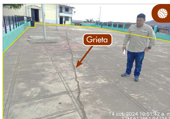
Figura 11. Plaza de Armas de Sapillica y patio contiguo, afectados por inundaciones pluviales (polígono amarillo) durante los periodos de lluvia intensa. El agua acumulada se infiltra hacia la parte inferior de la losa de concreto y afecta las oficinas del Palacio Municipal de Sapillica.
