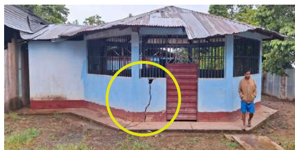
Figura 17. El local usado como comedor de la institución educativa también fue afectado por el deslizamiento. Este presenta grietas en la parte estructural de la infraestructura, con aberturas de 6 cm.
