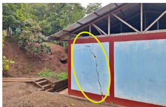
Figura 16. Parte lateral del aula agrietada por la reptación de suelos. La abertura de la grieta es de 4 cm.
