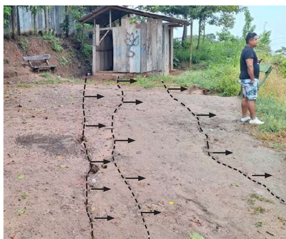
Figura 14. Agrietamientos identificados en la entrada de la I. E. n.º 0692-Progreso, con orientación noreste-suroeste.
