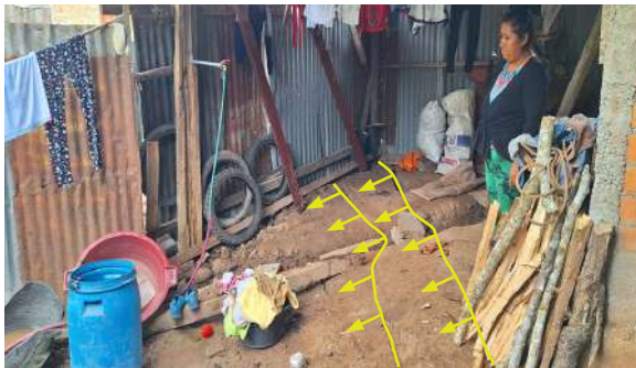
Figura 20. Agrietamientos en viviendas, con orientación noreste-suroeste, como consecuencia del deslizamiento de suelos de tipo rotacional.
