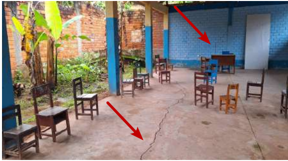
Figura 19. El local de eventos de la I. E. presenta agrietamientos en las paredes y piso (indicado con flechas rojas), como consecuencia del deslizamiento.
