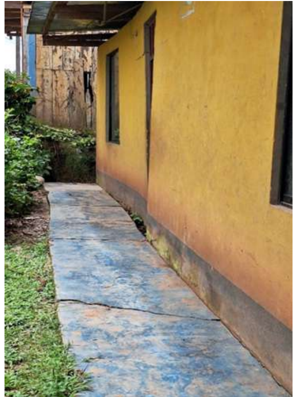
Figura 22. Desplazamiento lateral de la vivienda que se encuentra dentro de la influencia del deslizamiento de suelos. Se identificaron también grietas en la vereda.
