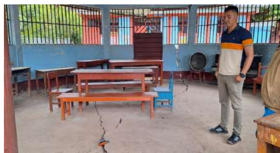
Figura 18. El comedor de la I. E. presenta grietas en la pared y piso, con aberturas de 6 cm y profundidad de 24 cm, con orientación N185°.
