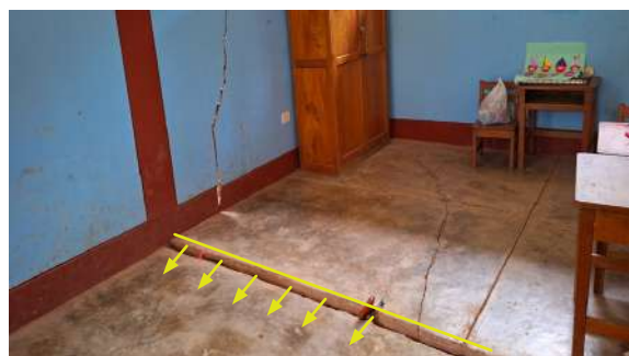
Figura 15. Las aulas de la I. E. n.º 0692-Progreso quedaron afectadas por los agrietamientos, producto del deslizamiento.
