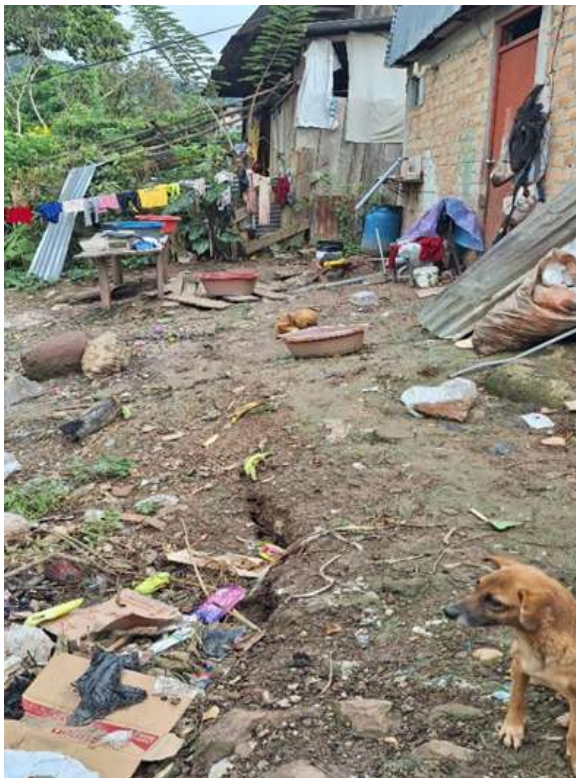
Figura 21. Agrietamiento en la parte posterior de las viviendas, como consecuencia del deslizamiento de suelos, con aberturas de hasta 32 cm, salto de grieta de 40 cm y profundidad de 65 cm, con orientación noreste-suroeste.
