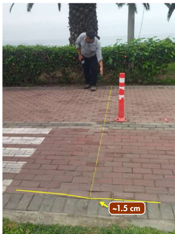
Figura 11. Evidencia de hundimiento leve, del orden de 1.5 cm, registrado en el malecón Godofredo García, al sur del parque Bernales.
