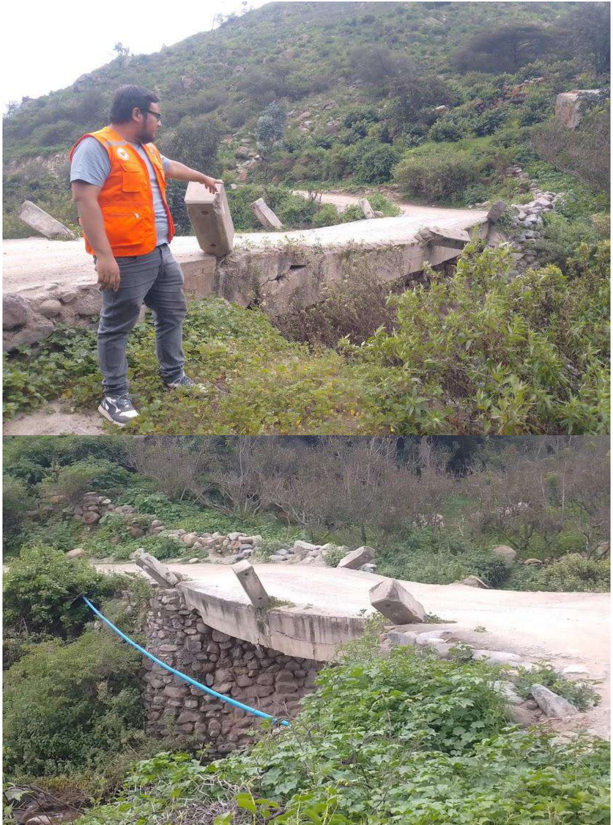
Figura N°49. Ubicación de la zona crítica – Puente Huaycho
