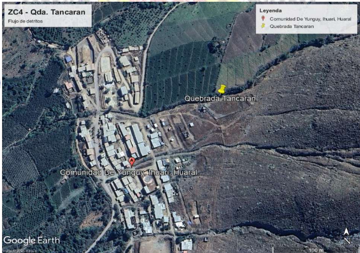
Figura N°40. Ubicación de la zona crítica – Qda. Tancaran
