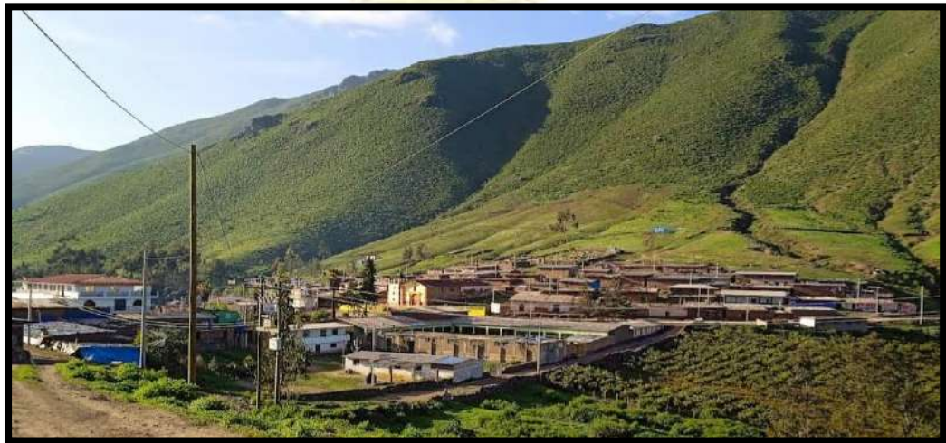
Figura N°33. Vista panorámica de la zona crítica – Quebrada Peña Rajada.
