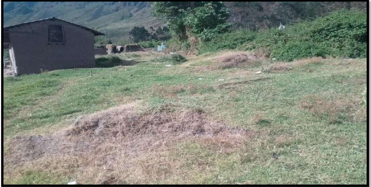
Figura N°36. Vista panorámica de la zona crítica – Quebrada Tucuay
