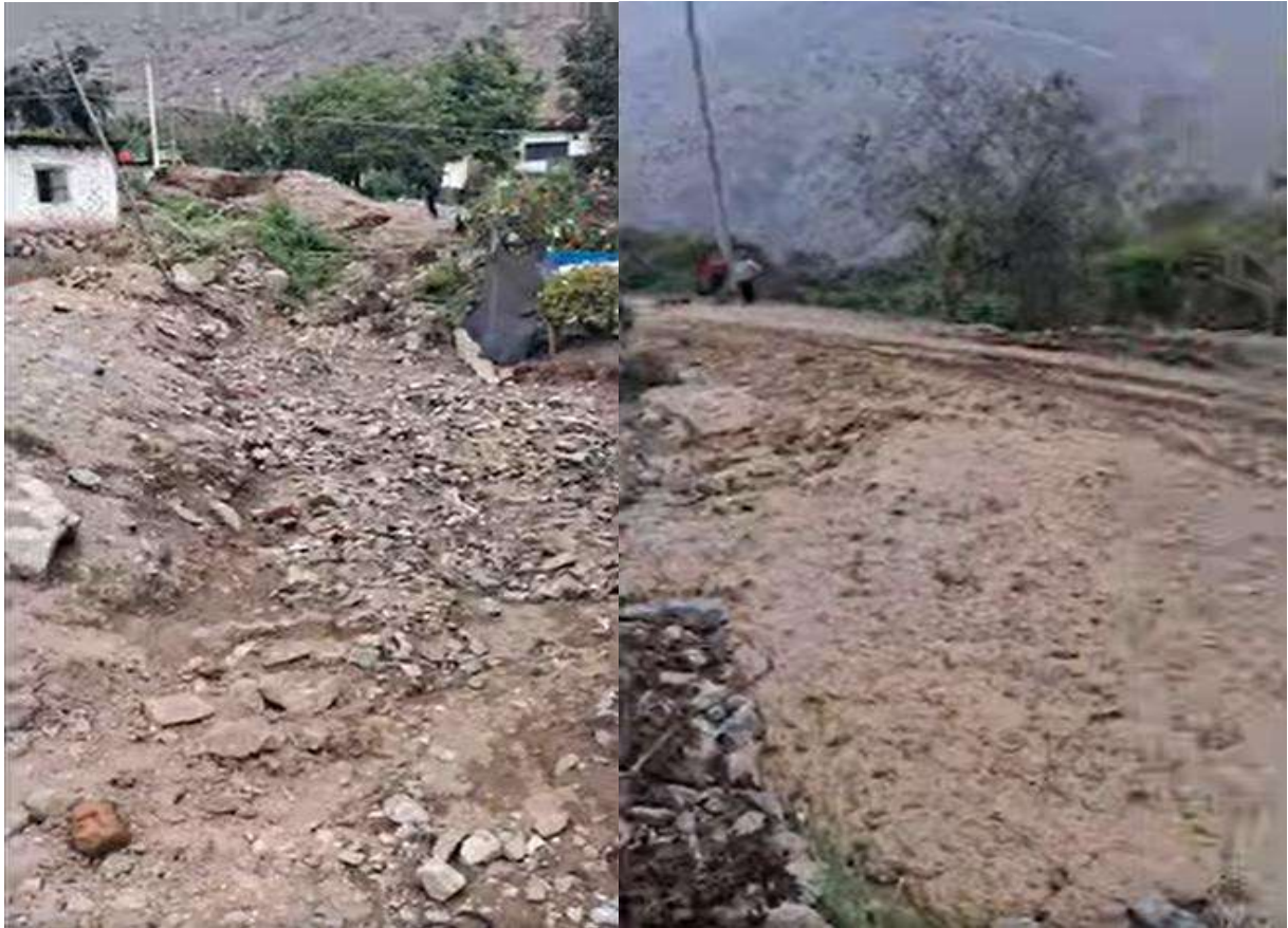
Figura N°41. Afectaciones del último evento (2023) de flujo de detritos en la C.C. Yunguy
