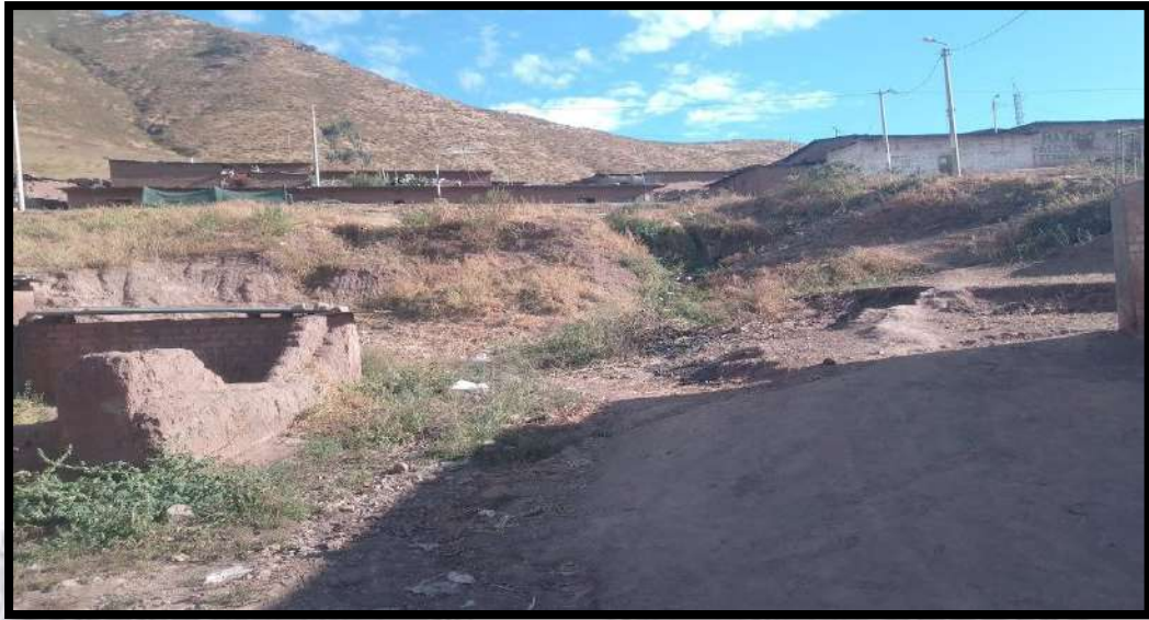
Figura N°34. Vista panorámica de elementos expuestos y viviendas afectadas
