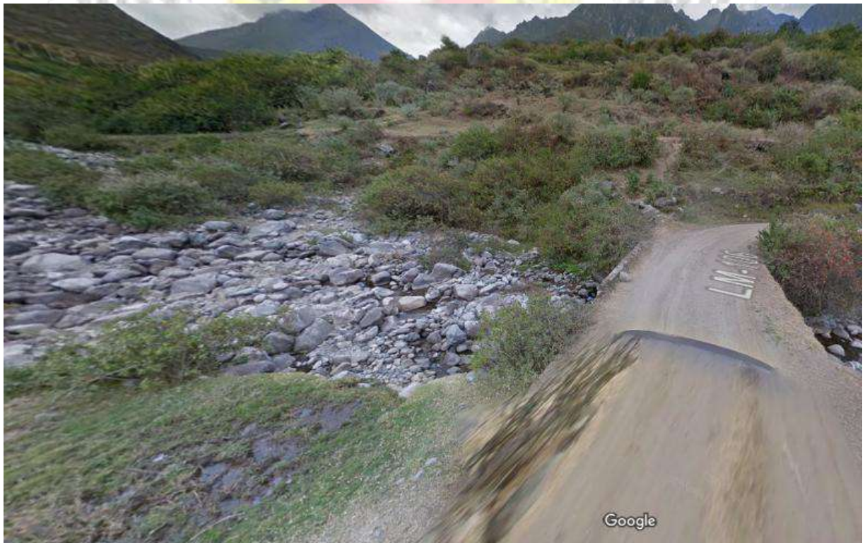
Figura N°51. Ubicación de la zona crítica – Puente Ocupampa
