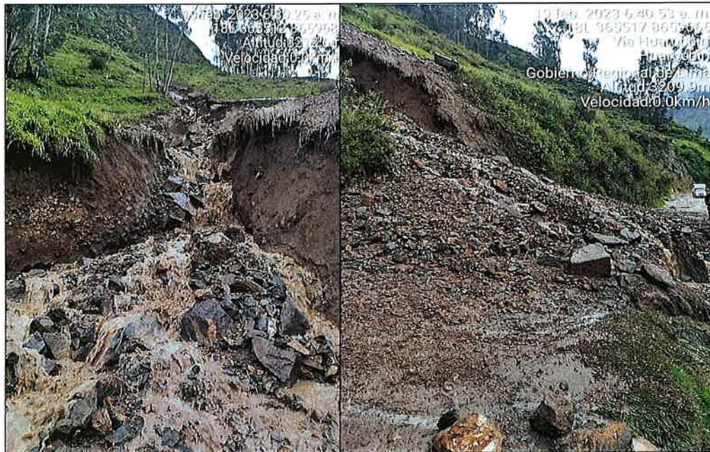
Fotografía 5. Flujo de Detritos en el Anexo de Anchucaya
