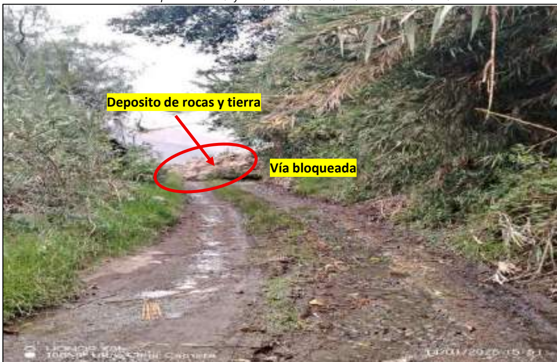
Ilustración 19: Deposito de rocas y tierra en la trocha carrozable debido al deslizamiento.
