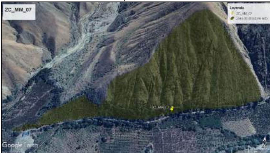
Ilustración 18: Zona Crítica por deslizamiento en el sector Mataca.
