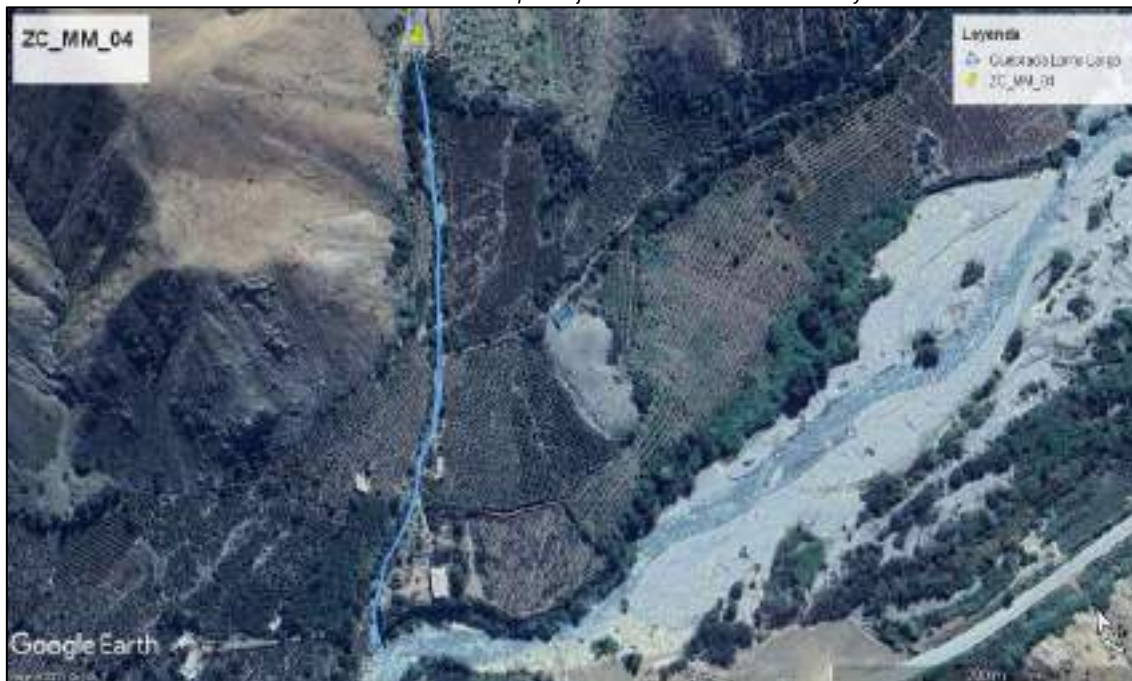
Ilustración 12: Zona Crítica por flujo de detritos en el sector Huayo.
