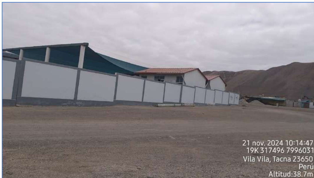
Fotografía 12 – Vista lateral Cerco perimétrico de IIEE San pedro
