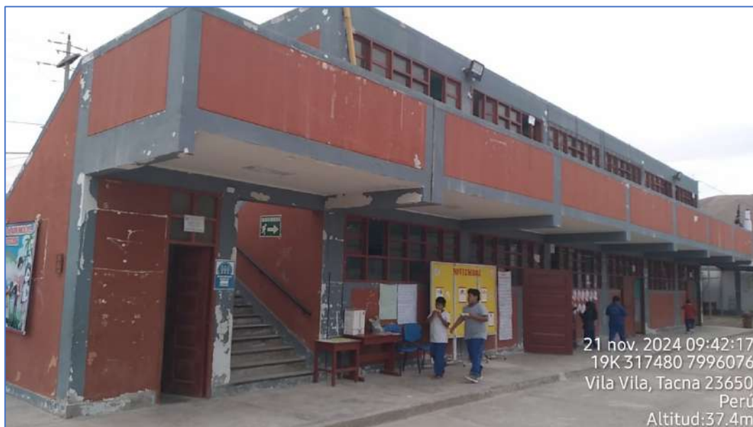
Fotografía 6 – Pabellón de 02 niveles de concreto armado.
