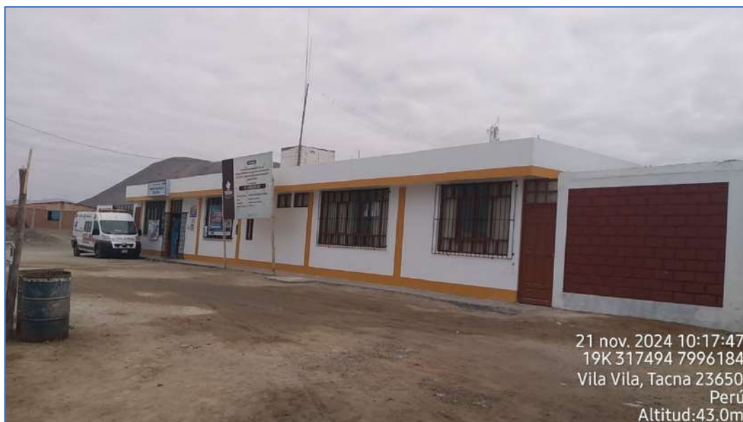
Fotografía 20. Elementos expuestos – Establecimiento de salud Vila Vila
