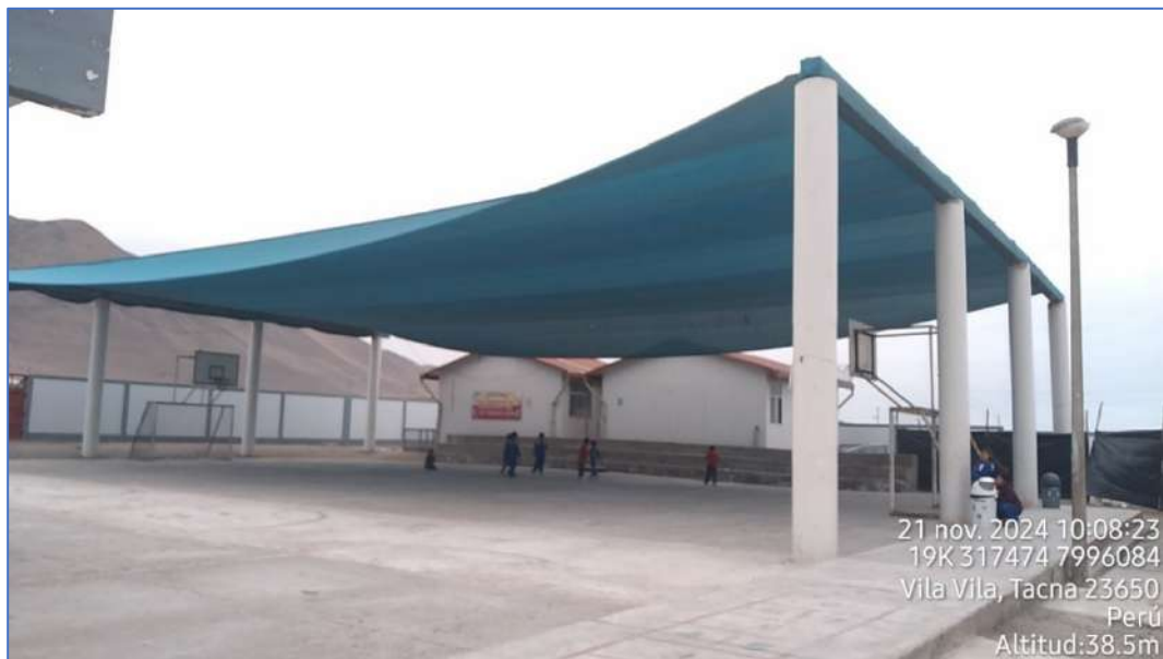
Fotografía 10 – Losa deportiva de concreto con cobertura de malla raschell.
