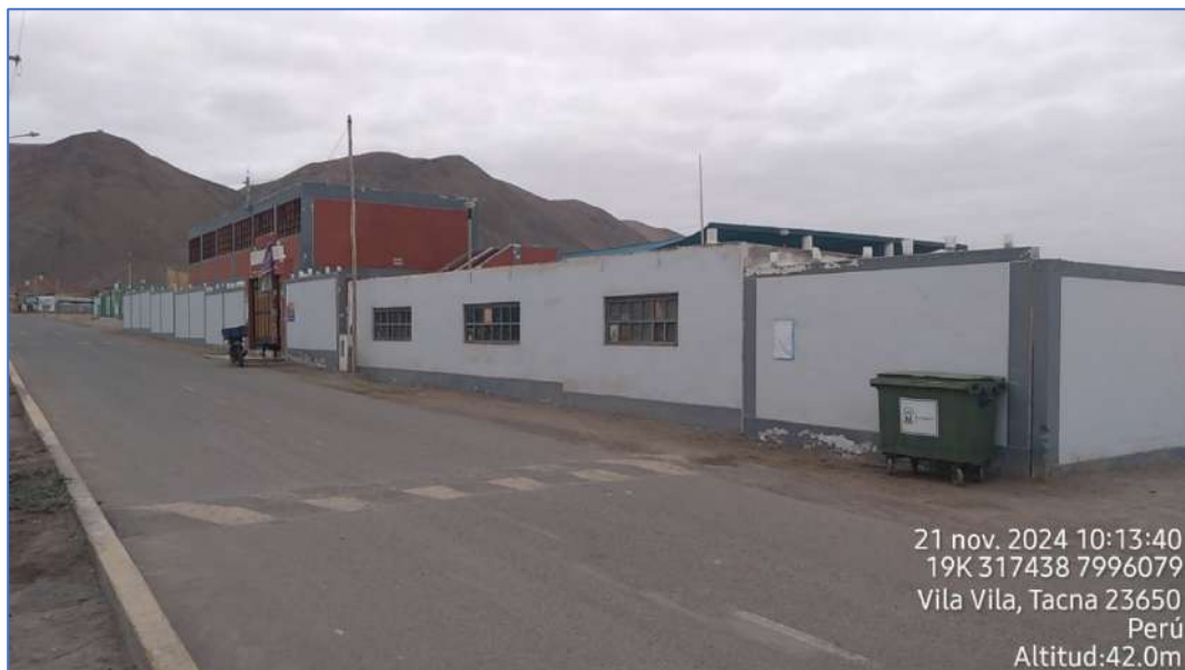
Fotografía 11 – Cerco perimétrico de IIEE San pedro
