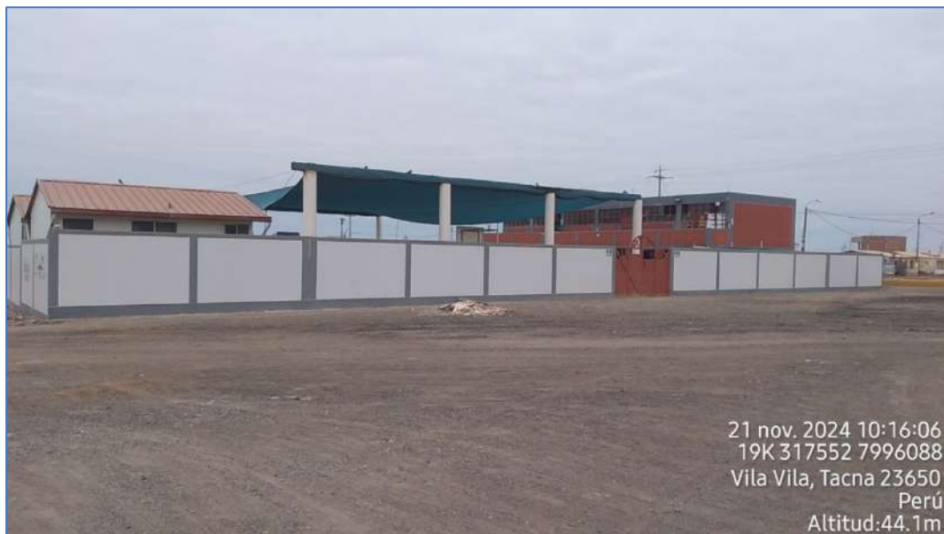
Fotografía 13 – Vista lateral Cerco perimétrico de IIEE San pedro
