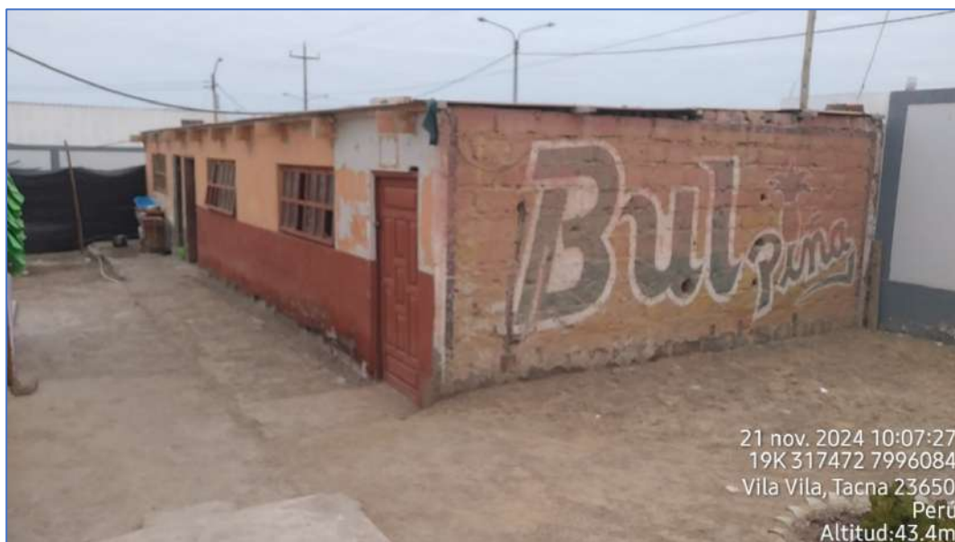
Fotografía 9 – Comedor y cocina modulo de bloquetas de concreto.
