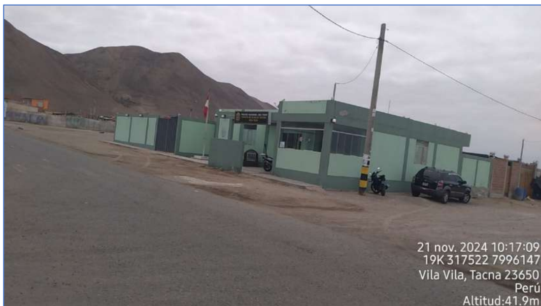
Fotografía 18. Elementos expuestos – Puesto de auxilio rápido Vila Vila
