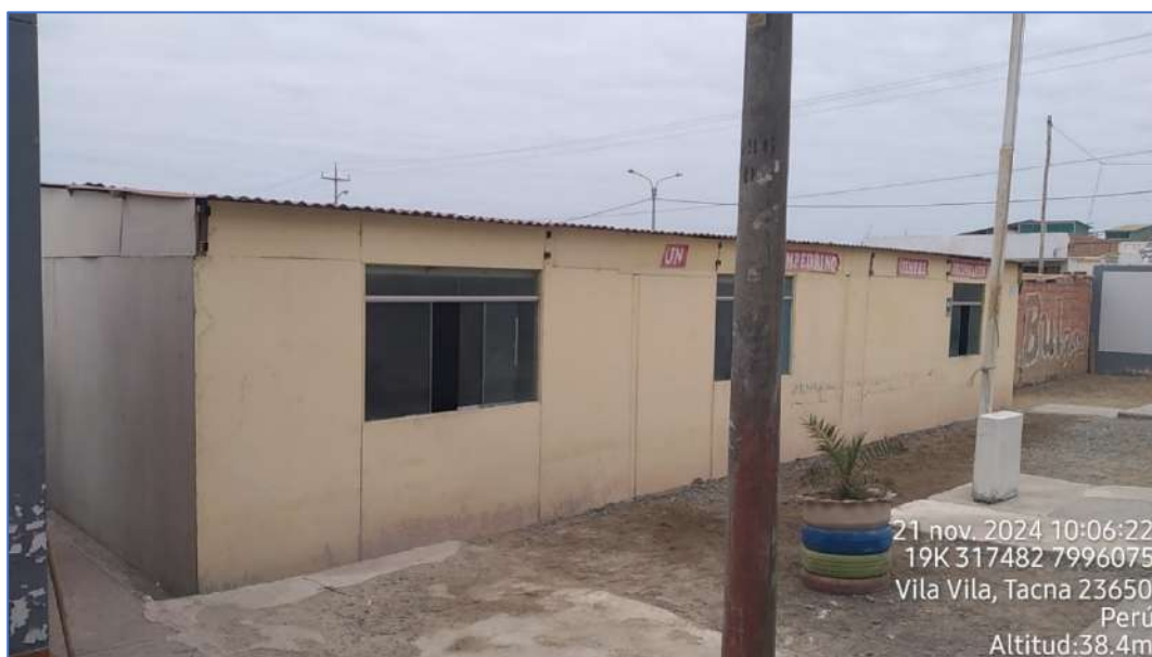
Fotografía 7 – Modulo temporal de paneles de triplay aula de 2do año de secundaria
