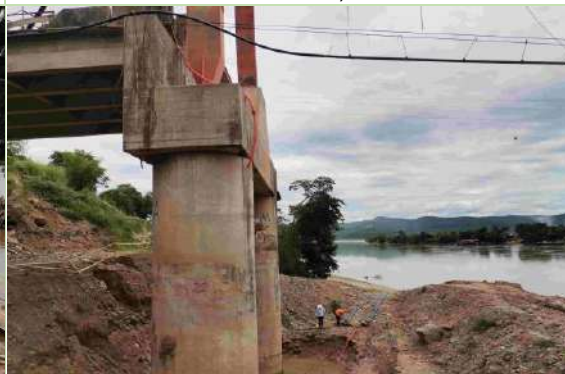
Foto N° 20: Puente Picota, desmantelado
