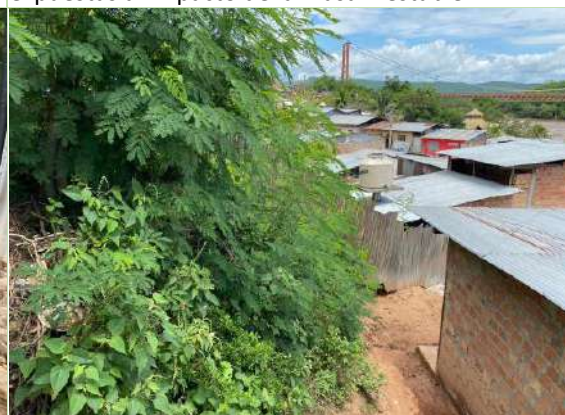
Foto N° 18: Viviendas en la parte baja de la ladera, expuestas al impacto de la masa inestable
