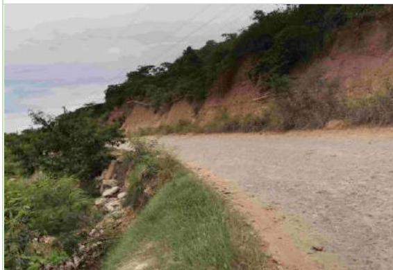
Foto N° 25: Carretera Nacional PE-5N
