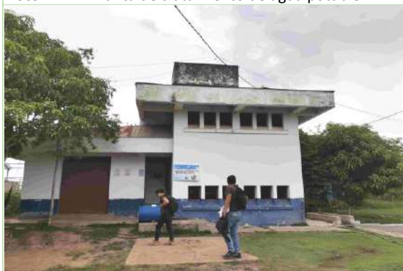
Foto N° 21: Planta de tratamiento de agua potable PTAP
