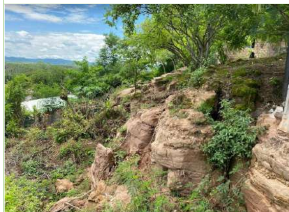
Foto N° 17: Rocas propensas a caer ladera abajo
