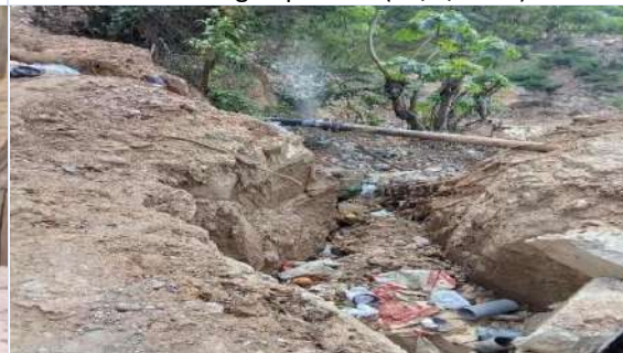
Foto Nº 12: Lluvias intensas Los Pinos y Primavera - Picota, 2 viviendas inhabitables (14/3/2020)
