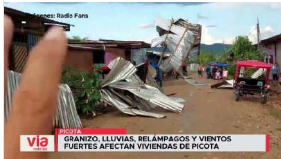
Foto Nº 9: Temporales Pumahuasi-Picota, vivienda inhabitable (31/7/2023)
