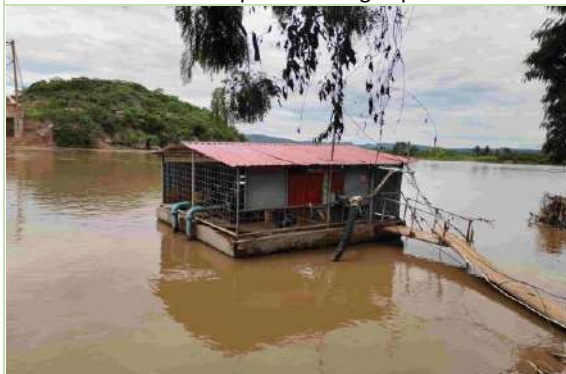
Foto N° 19: Captación de agua potable
