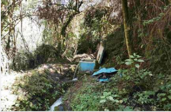
Caja de pase para entubado y/o conducción del agua Talud rocoso inestable (fracturada) con riesgo de desprendimiento y desplome.
