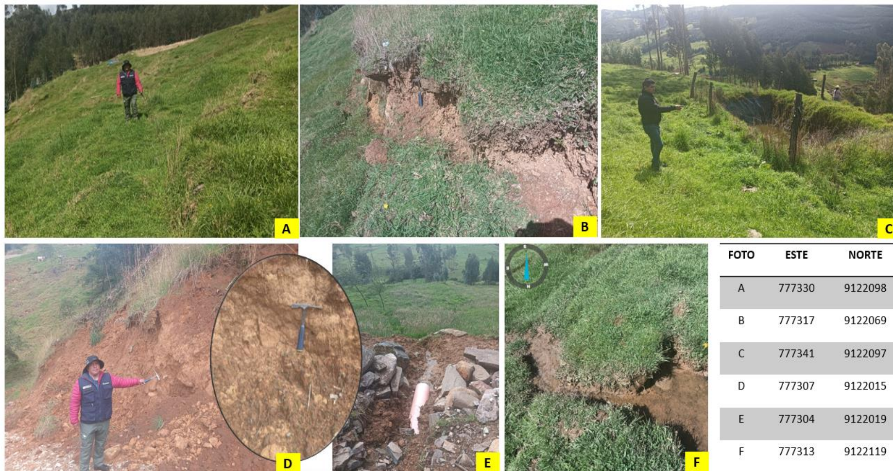
Figura 15. A. Escarpe secundario del deslizamiento. B. Escarpe secundario del deslizamiento con un salto de 0.48 m. de longitud, sobre material coluvio deluvial. C. Reservorio de 150 m^3 de capacidad afectado por el deslizamiento. D. Escarpa secundaria del deslizamiento colindando con la vía vecinal LI-805. E. Tubería de .6 pulgadas, que recepciona el caudal de las surgencias de agua, cruza la vía LI- 805 y desemboca tras cruzar la vía vecinal. F. Surgencias de agua sin canalizar.
