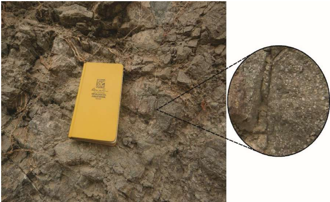
Figura 6. Afloramiento de rocas piroclásticas de composición andesítica del Grupo Carhuaz, muy fracturado, con espaciamentos entre sí que varían entre 10 a 20 cm.,
