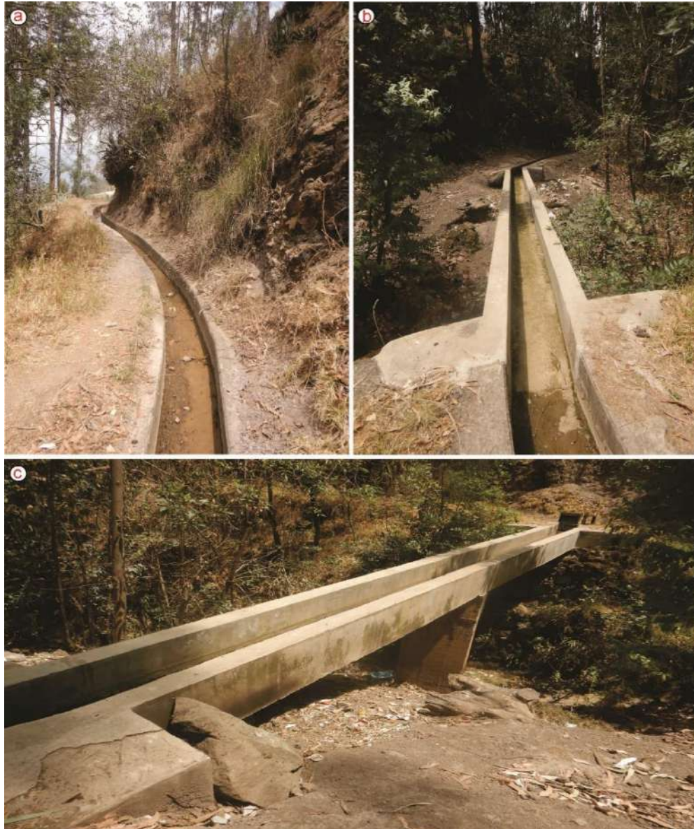
Figura 23. Se identificó canales de riego con revestimiento de concreto, en un tramo aproximado de 150 m parte del canal cruza la quebrada santa rosa, en un tramo de 15 m. aprox. Entre las coordenadas N8961288 N, 213474 E,
