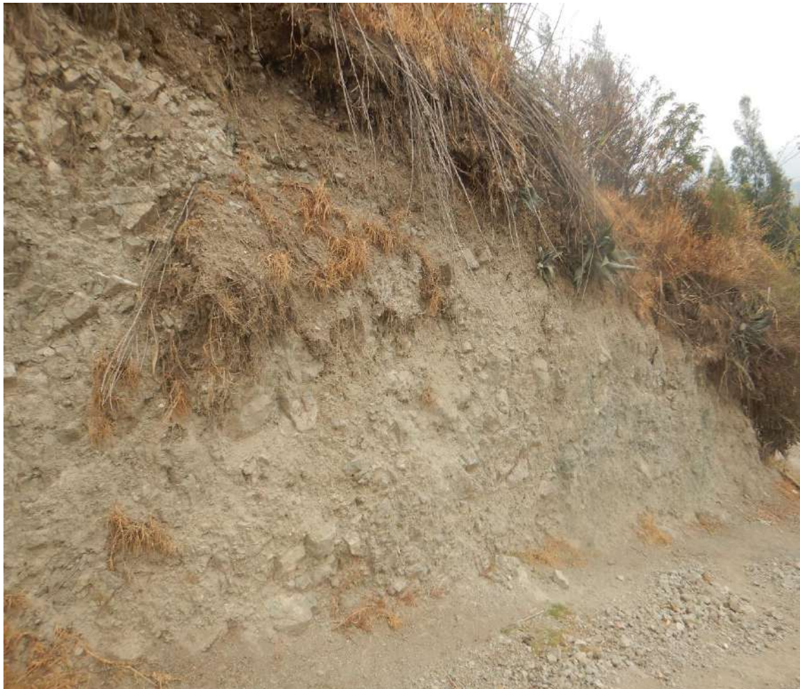
Fotografía 3. Vista del derrumbe, ubicado a un costado de la trocha carrozable, entre los sectores de Quillipururi – Tucururi, la cabecera de la misma se observó vegetación característica del sector.
