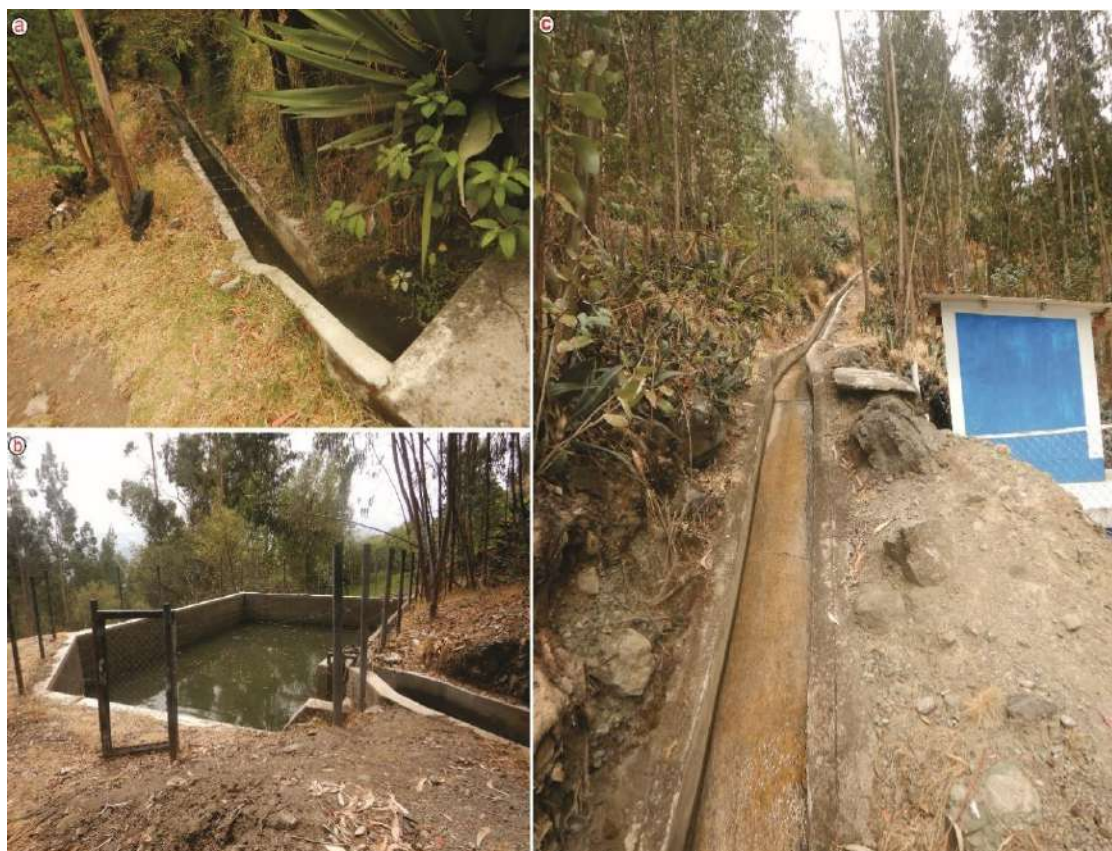
Figura 21. Tramos de canal de riego revestido, así como la presencia de un reservorio.
