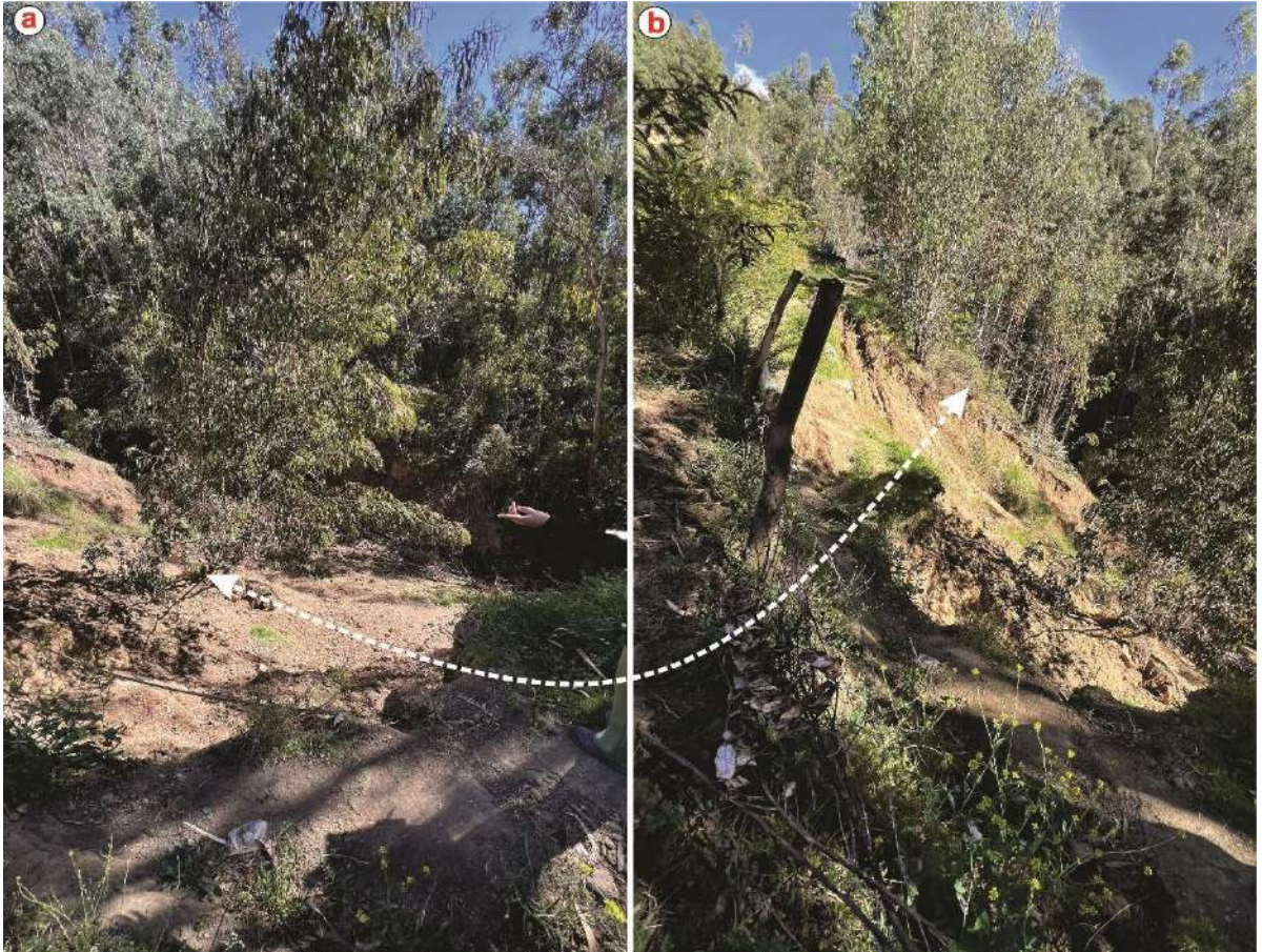
Figura 26. Cerca del escarpe del deslizamiento se observan arboles inclinados y otros próximos a ceder.
