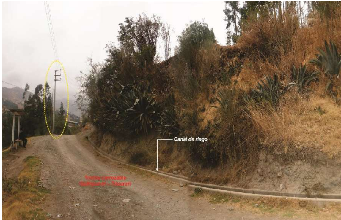
Figura 17. Tramo de la carretera, donde se observa el canal de riego de concreto; así como un poste de tendido eléctrico de concreto ubicado a 6 m del pie del derrumbe.
