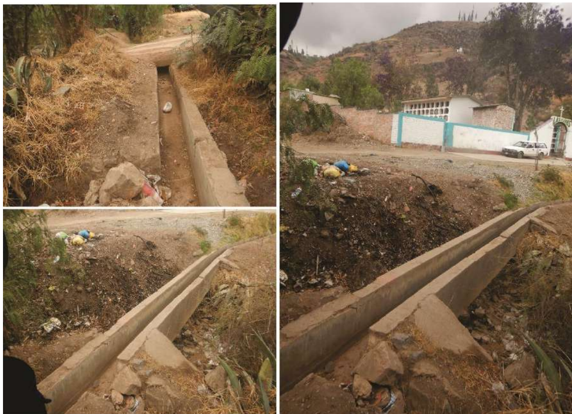
Figura 14. Canal de concreto que cruza por la quebrada, pasa por la frentera del cementerio.
