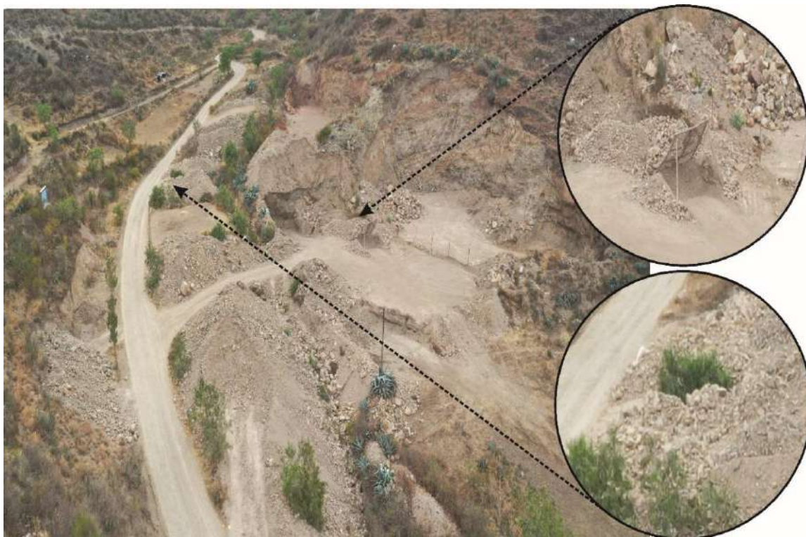
Figura 13. Vista panorámica con dirección al este de la quebrada donde se observa la cantera, así como el depósito de desmonte; estas ubicadas en medio de la quebrada.
