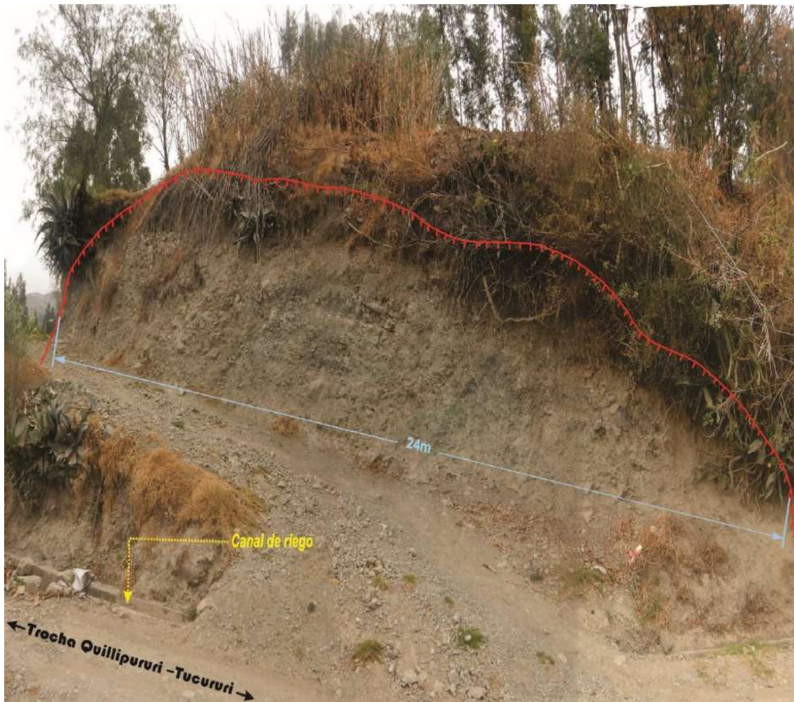
Figura 16. Arranque del derrumbe, afecta 10 a 12 m de la trocha carrozable; así como el canal de riego de concreto, ubicado al pie del derrumbe.
