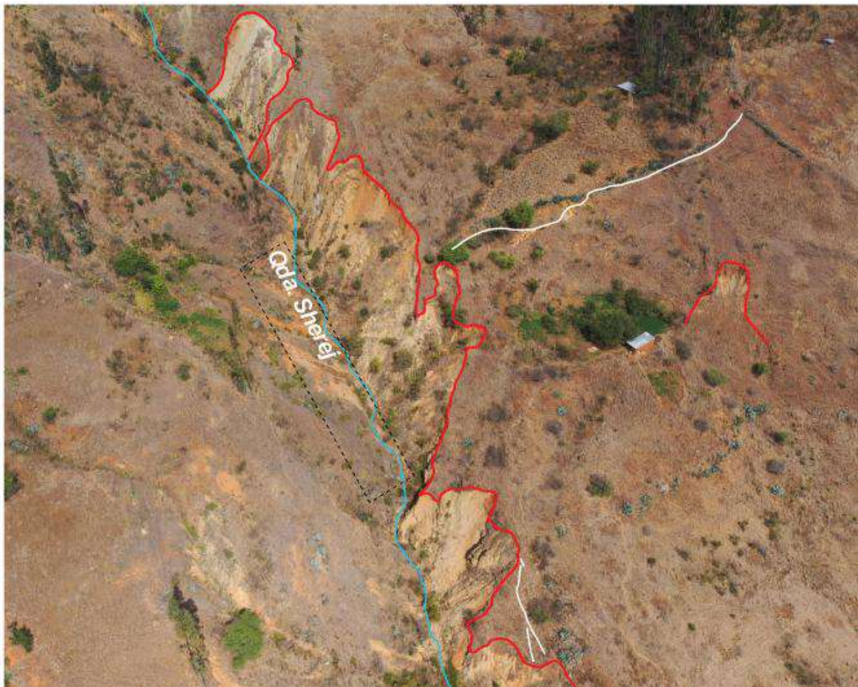
Figura 12. Vista de derrumbes continuos en la margen izquierda de la quebrada Sherej.
