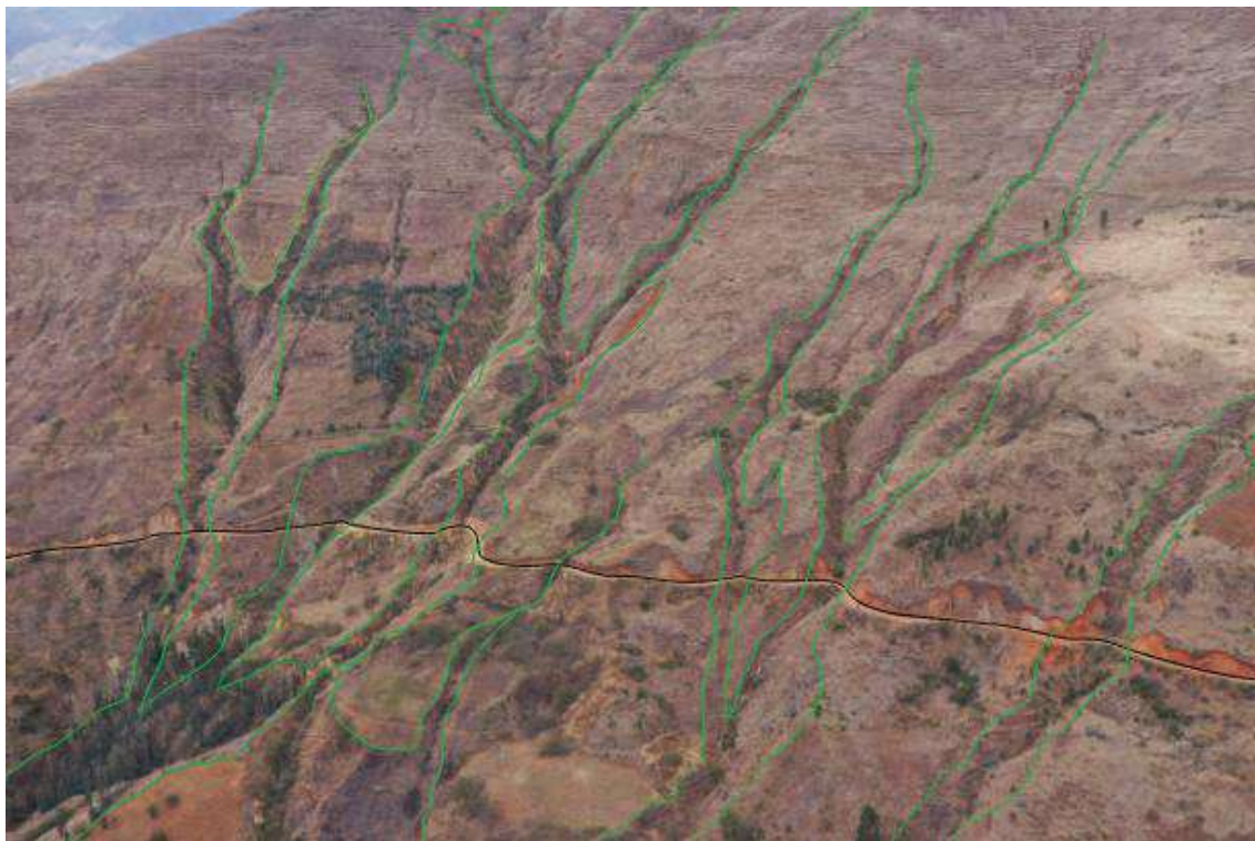
Figura 13. Vista de procesos de erosión de ladera en cárcavas que podría acarrear flujo en temporada de lluvias intensas y/o prolongadas.
