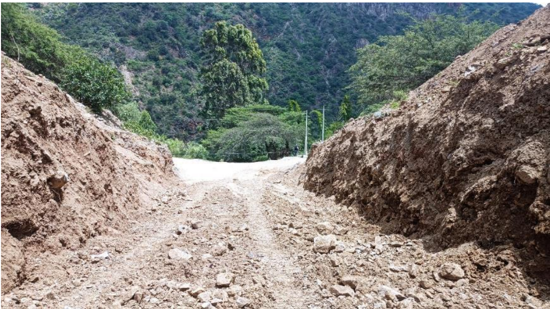
Figura 12. Quebrada Tingo vista hacia la trocha carrozable principal vía de acceso.
