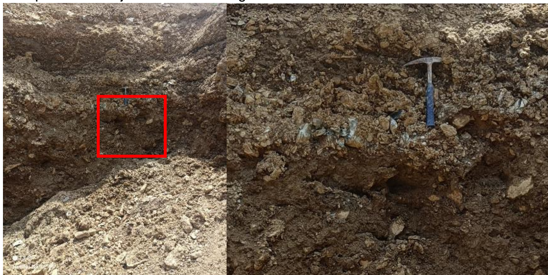
Figura 14. Sección transversal del deslizamiento rotacional activo y el deslizamiento traslacional.
