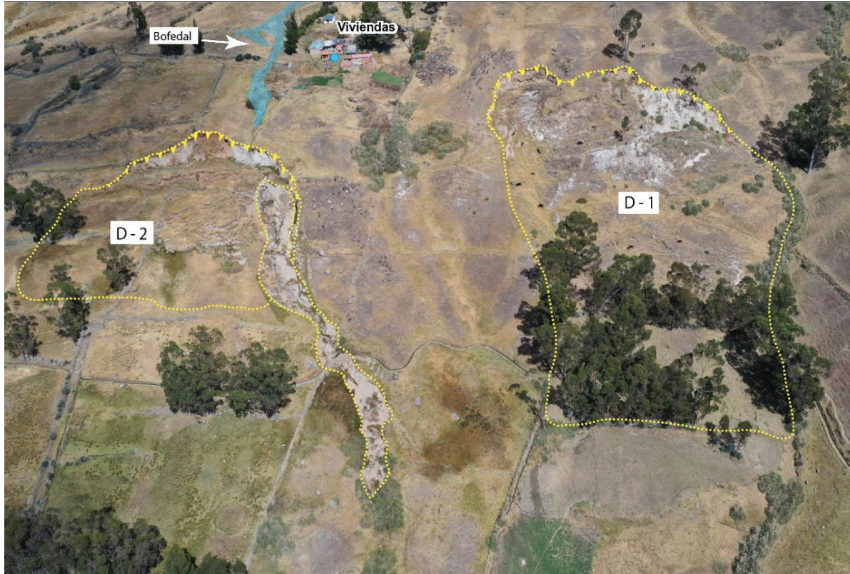
Figura 18. Vista de viviendas ubicado aproximadamente a 70 m ladera arriba de la corona del deslizamiento D-2, podrían ser afectados si el deslizamiento siga con avance retrogresivo.
