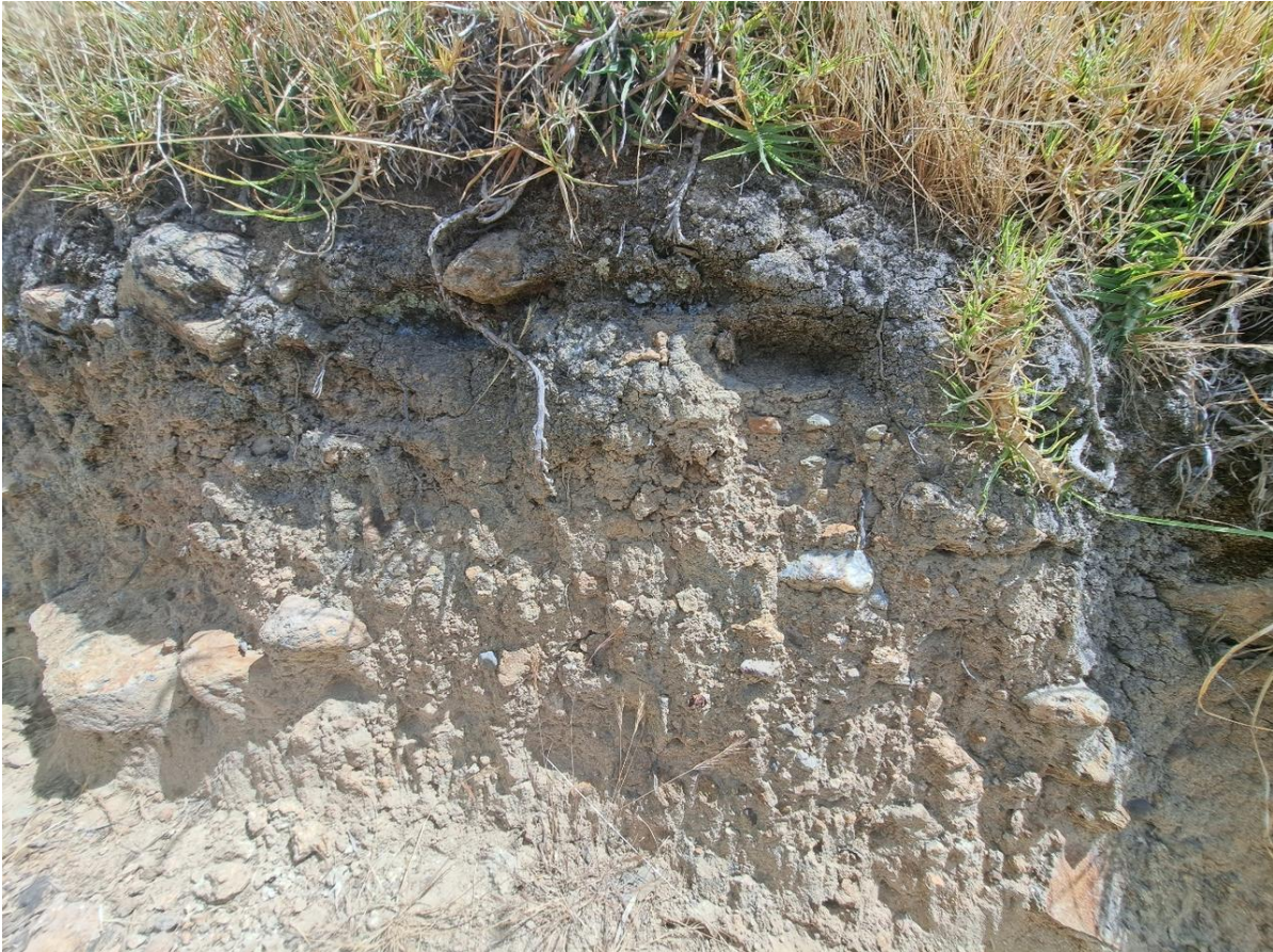
Fotografía 2. Depósito coluvio-deluvial compuesto por fragmentos angulosos a subangulosos de roca de 10 cm a 25 cm (10%), gravas (40%) y matriz limoarcilloso (50%).
