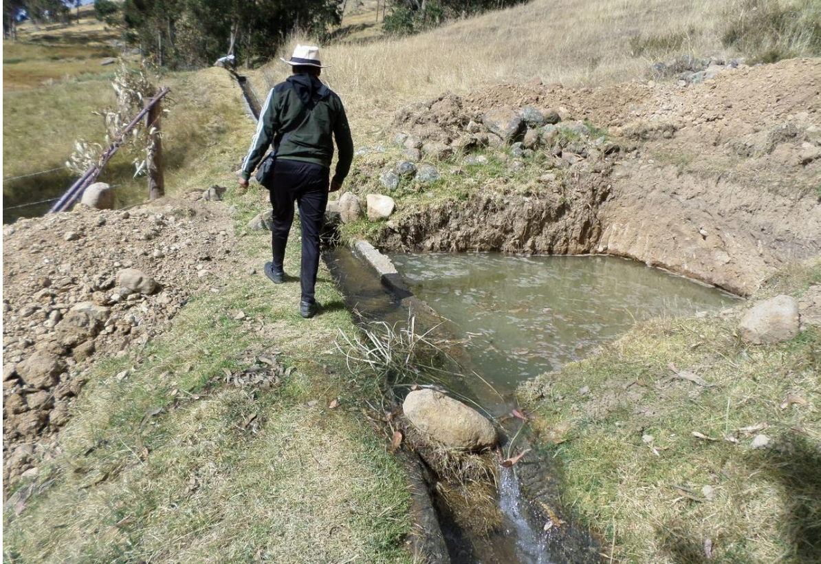
Fotografía 4. Vista de pozo rustico no impermeabilizado, usado como reservorio de agua para riego.
