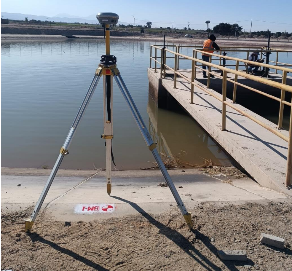
COLOCACION DE PUNTOS DE CONTROL
