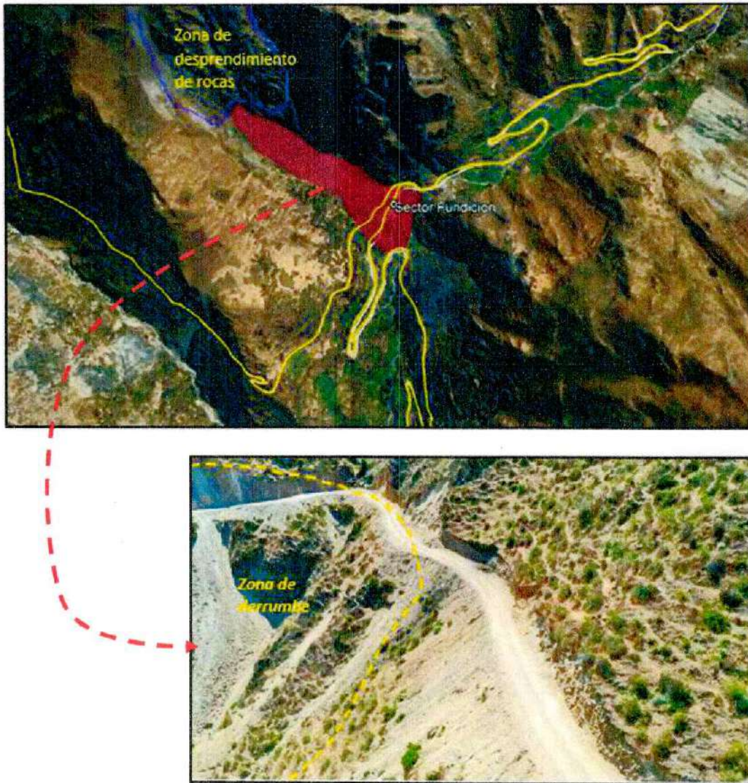
Figura N° 31. Zona crítica Fundición, Vichaycocha presenta derrumbe de rocas.
