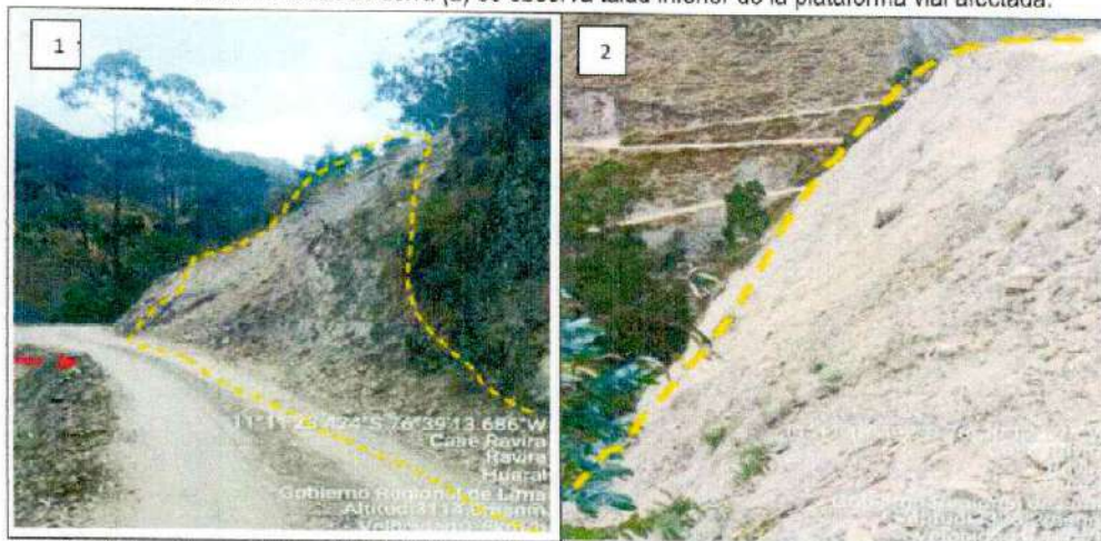
Figura N° 36. Zona crítica entrada a Pacaraos, se observa caída de rocas y tierra afectando la vía LM-621 (1) Se observa caída de tierra (2) se observa talud inferior de la plataforma vial afectada.
