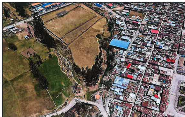
Fotografía 6. Flujo de Detritos en la Quebrada Huaychica
