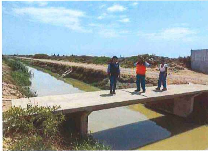
Figura 22 Fotografía del Punto Crítico 2.
