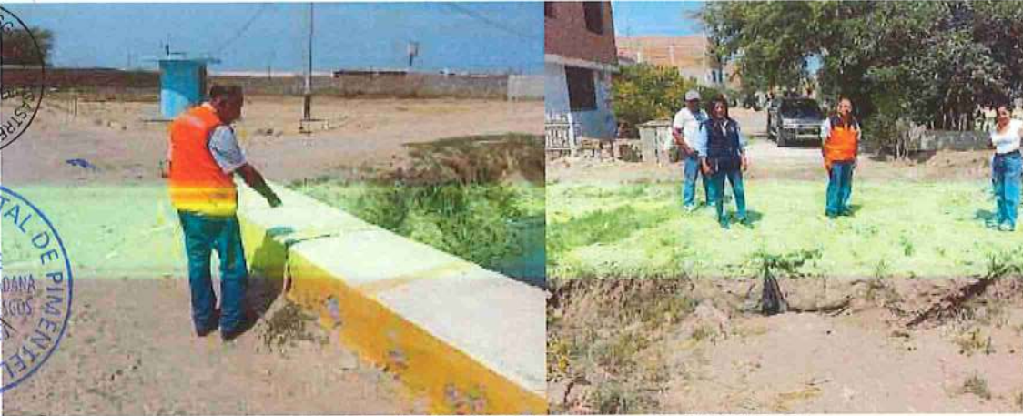
Figura 21 Fotografía del Punto Crítico.
