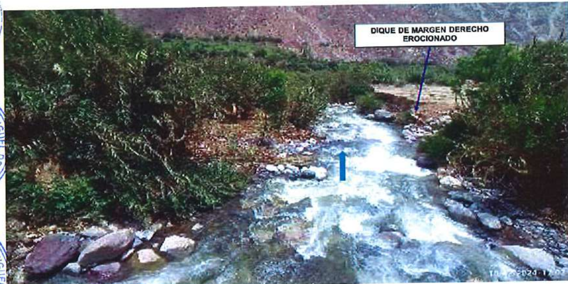
Figura N° 43. Zona crítica del puente Acos presenta fujo de detritos y erosión fluvial
