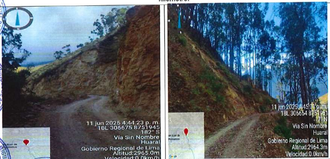
Figura N° 32. Zona crítica sector Huascoy presenta caída de rocas se observa un tramo afectado de 1 kilómetro.
