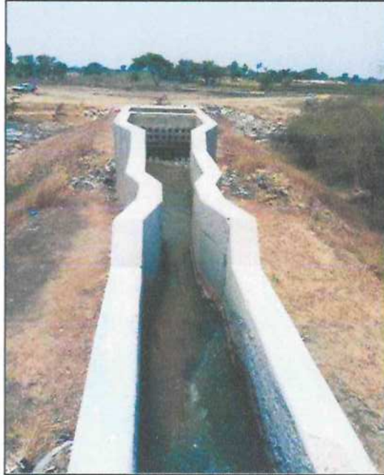
Imagen 21. Ingreso de agua residual a la PTAR.
