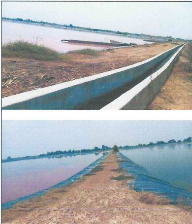
Imagen 22. PTAR del Distrito de Pueblo Nuevo.
