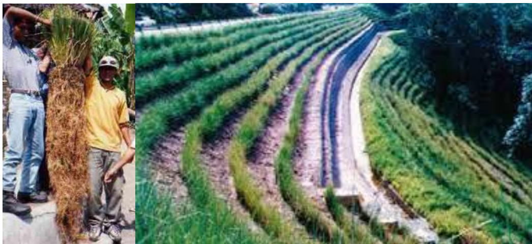
Fotografía 2. Ejemplo de bioingeniería con arbusto (vetiver) en taludes de materiales sueltos.
