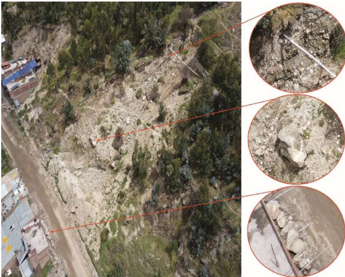
Figura 31. Vista de bloques de 0.50 a 2.8 m de longitud colgados en la ladera y otros se encuentran aislados, con bloques en la frentera de las viviendas; actualmente utilizado como muro rustico, como medida de protección.
