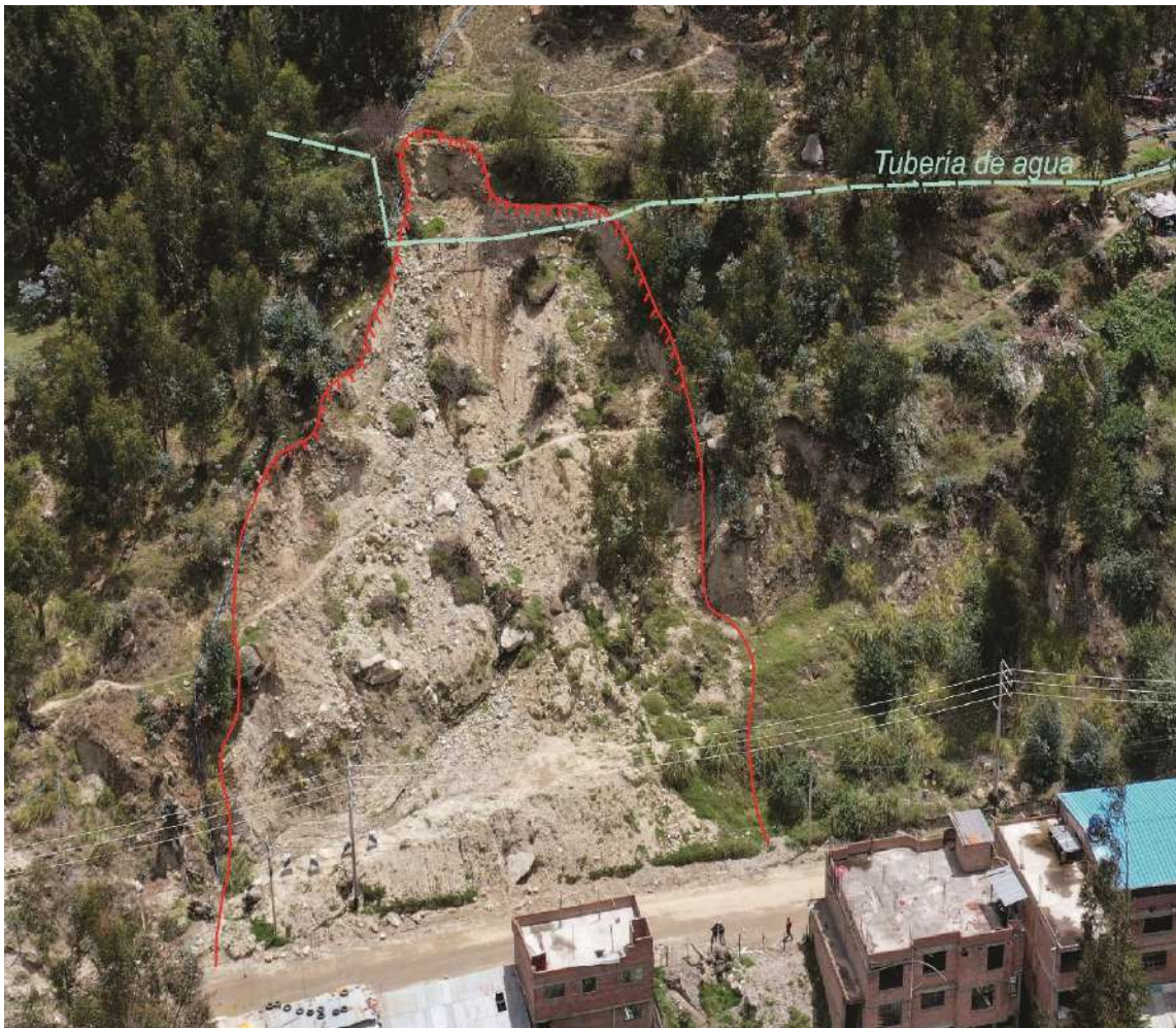
Figura 28. Vista frontal del derrumbe, el cual se ubica en la margen izquierda de la quebrada Llaca.
