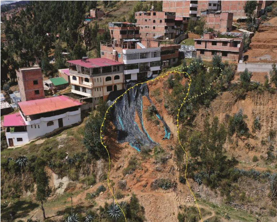
Figura 20. Vista del deslizamiento rotacional activo y antiguo del sector El Pinar. Se delimitaron el deslizamiento activo (con línea continua) y el deslizamiento antiguo (con líneas separadas).
