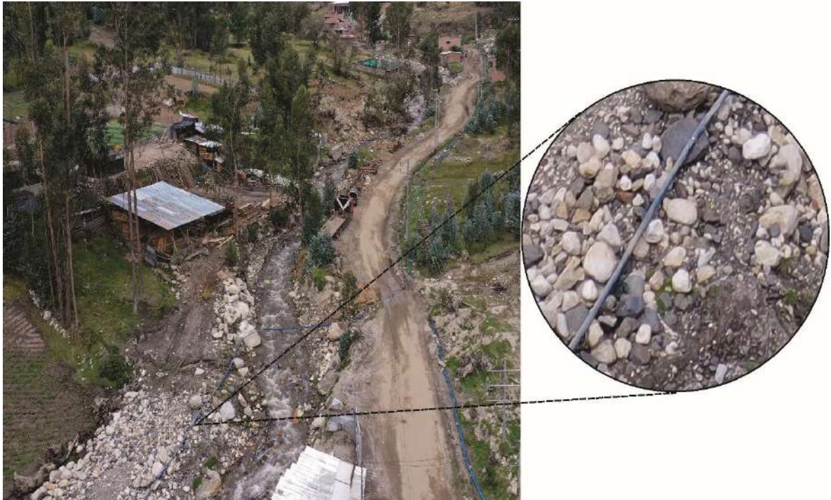
Figura 11. Depósitos aluviales identificados en ambas márgenes de la quebrada Llaca, en algunos sectores dentro de esta unidad se asientan algunas viviendas.
