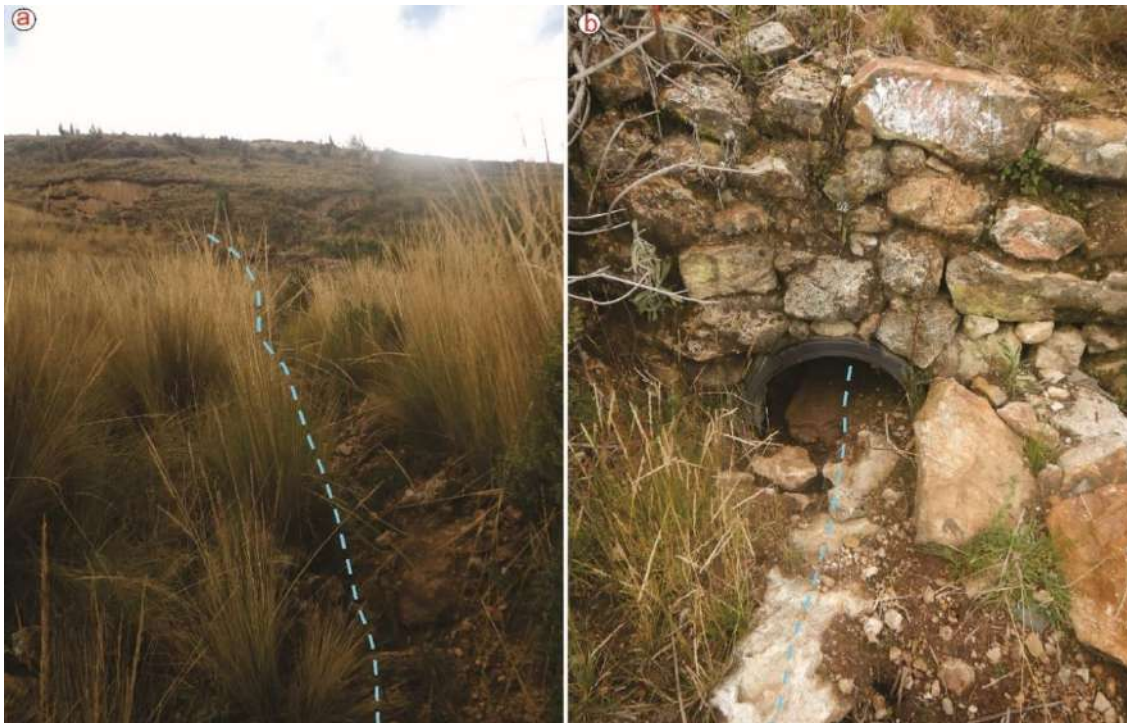
Figura 35. Se evidenció tubería interna, actualmente no se evidencia presencia de agua.
