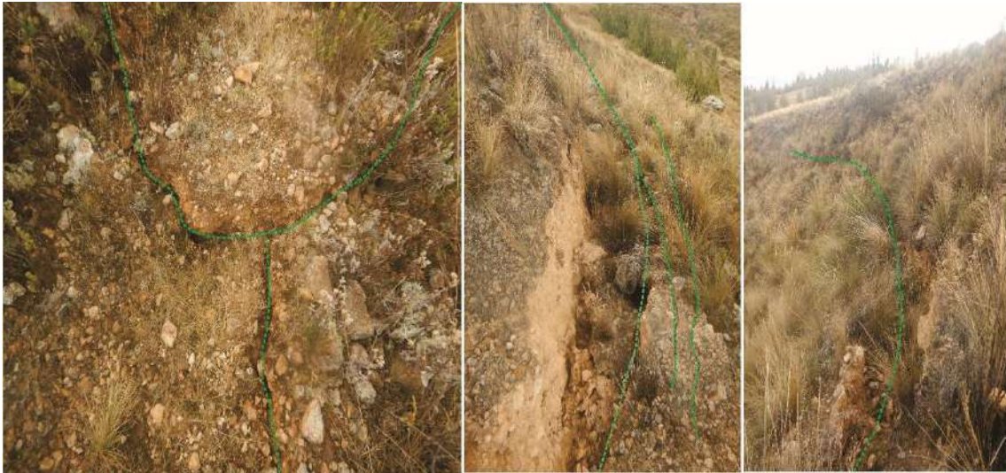
Figura 36. Grietas longitudinales en dirección hacia el este. Estas presentan abertura de 5 a 10 cm, profundidades visibles de 3 a 5 cm y longitudes de 0.50 a 3 m.
