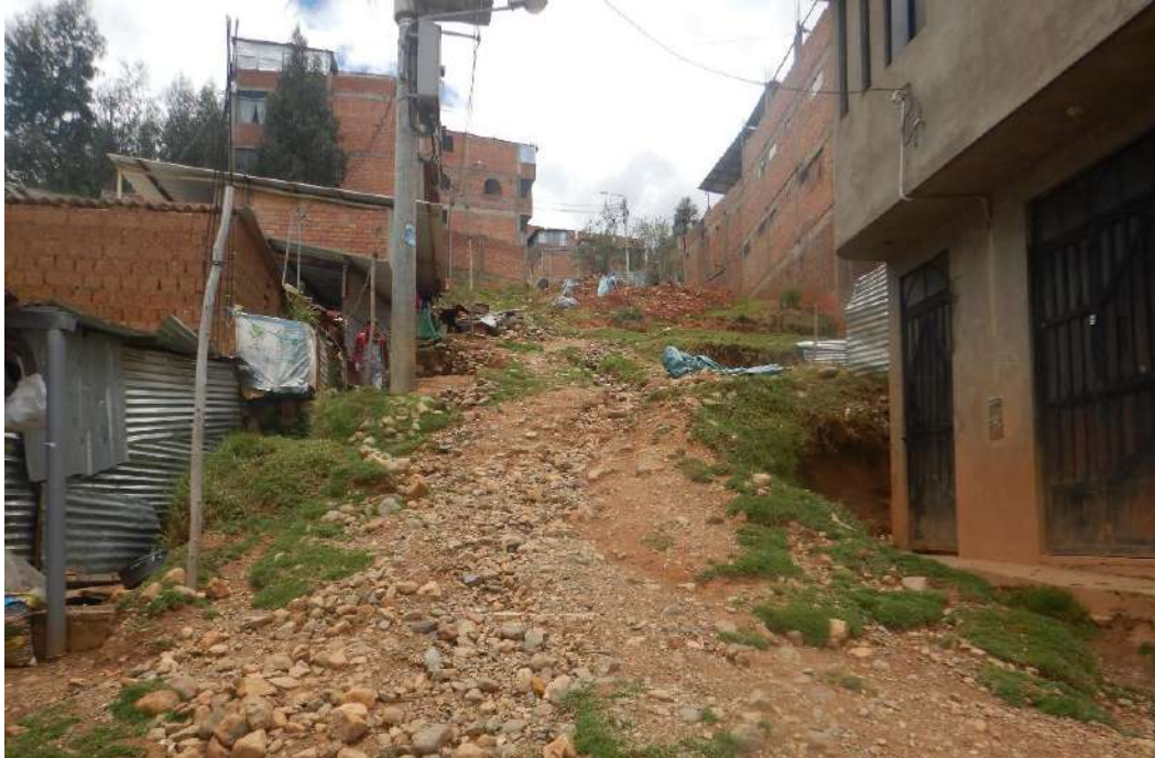
Fotografía 1. Construcción de viviendas de material noble, con construcciones de hasta 4 pisos en el sector Pasamayito.
