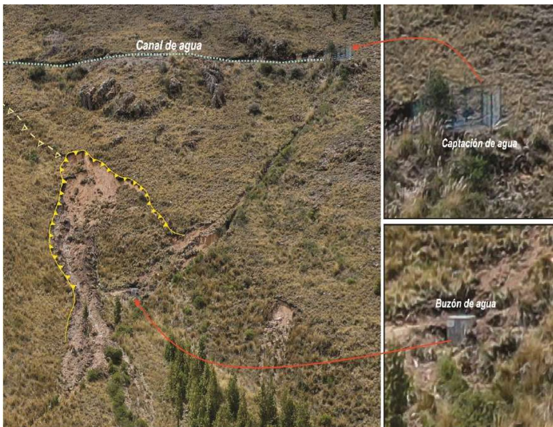
Figura 33. Vista del deslizamiento activo, en donde se observa un buzón de concreto en medio del cuerpo; así como un buzón de captación en la parte izquierda superior del deslizamiento.
