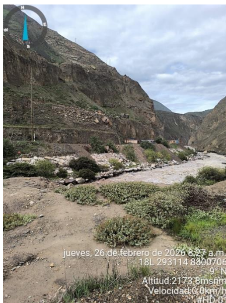
Fotografía N° 01. Cauce del río Checras – Presencia de rocas y vegetación
