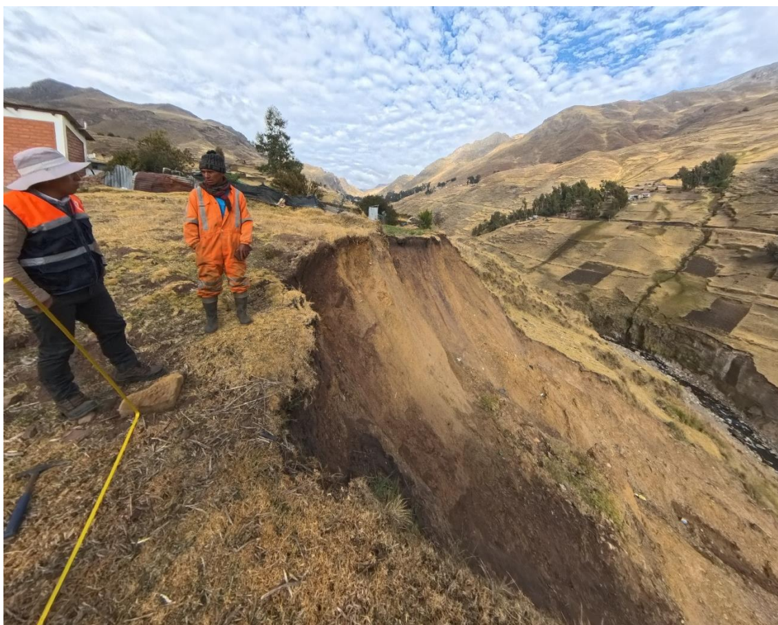
Fotografía 3. Escarpes activos con una altura de 2.3 m. Además, obsérvese la saturación del suelo. Coordenadas referenciales UTM WGS-84, 18S: E: 518775; N: 8555960.
