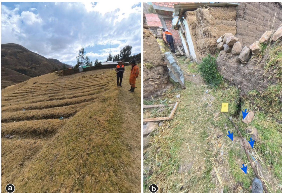
Figura 14. a. Cultivos de papa, ubicado por encima de los escarpes activos. b. Direccionamiento de desagüe directamente al suelo, lo que genera mayor erosión e inestabilidad en el terreno por saturación del suelo
