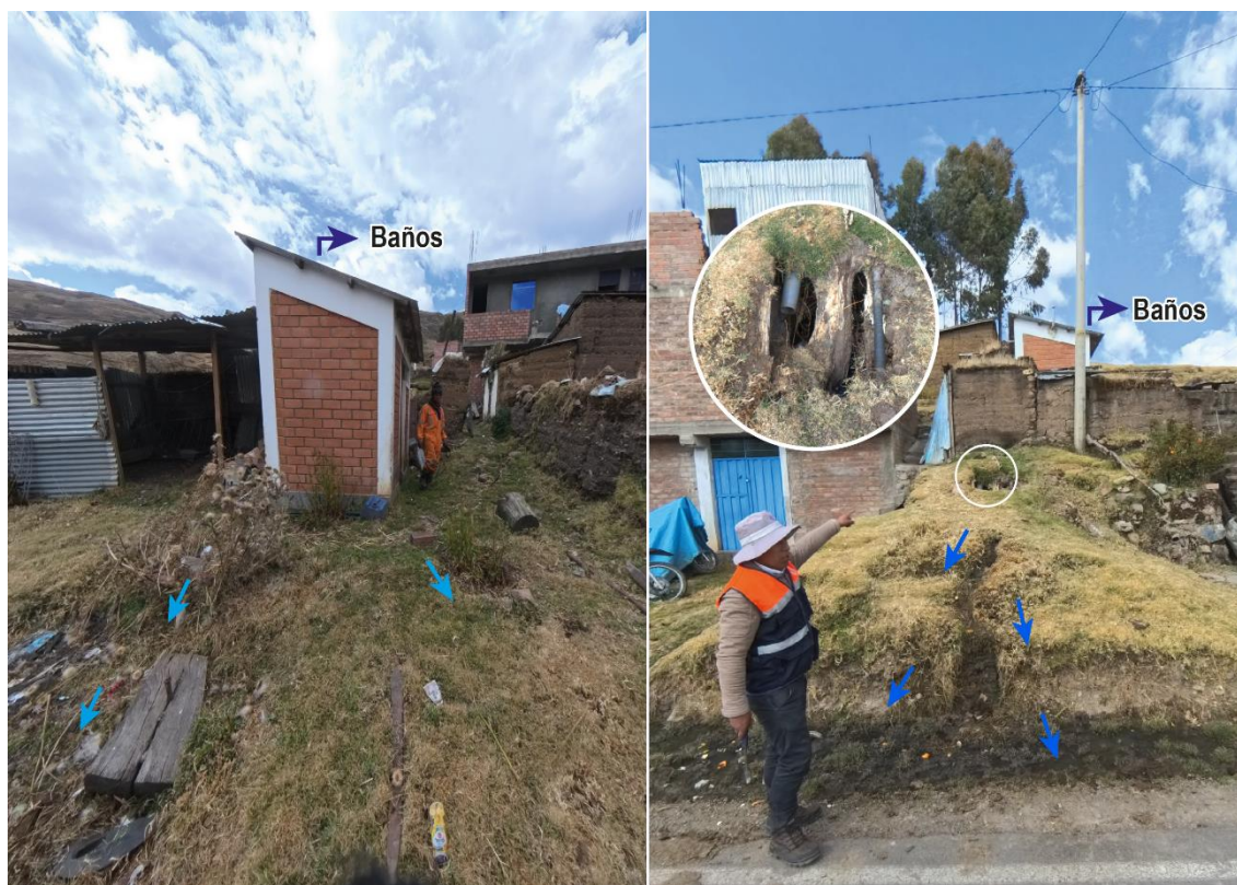
Figura 12. Vista de unidades básicas de saneamiento (baños) con mini sistemas de percolación (tanques sépticos), donde el afluente líquido se dispersa e infiltra fácilmente en el terreno (flechas de color azul), lo que incrementa la humedad del terreno y reduce la resistencia al corte del suelo.
