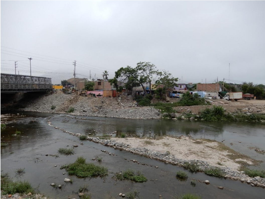
Fotografía 1. Centro poblado Sifón, asentado en la margen izquierda del río Chancay, que podría ser afectado por flujo de detritos y/o erosión e inundación fluvial.
