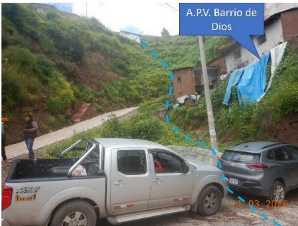
Figura 11: Limite entre la A.P.V. Barrio de Dios y José María Arguedas, vista tomada desde la Av. J.M. Arguedas. En la parte alta de la cárcava se aprecian muros de contención realizada para la vía. Coordenadas referenciales UTM WGS-84, 19S, E:8501481; N:177558.
