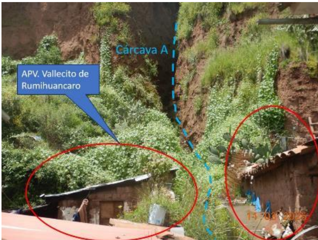
Figura 10: La A.P.V. Vallecito de Rumihuancaro se ubica en la confluencia de la cárcava con el río Huancaro, este sector presenta depósitos que están invadiendo a las viviendas
