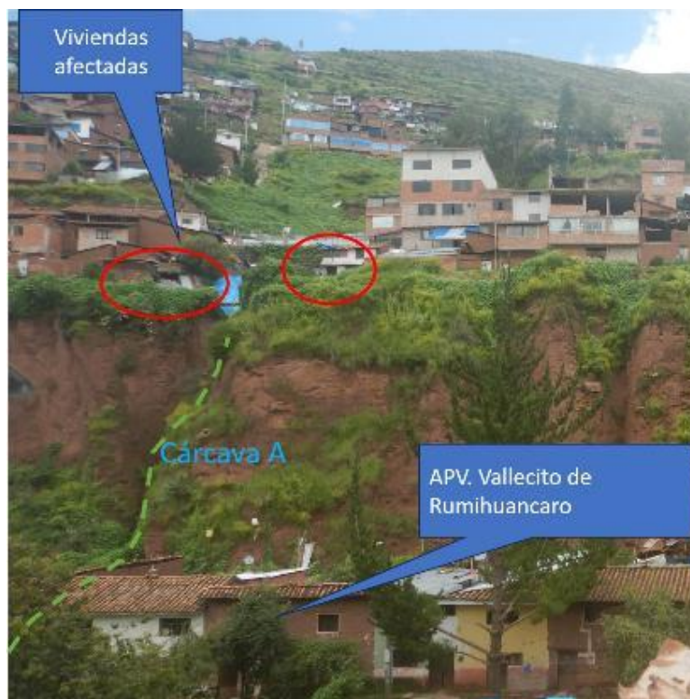
Figura 6: En círculos rojos las viviendas que pueden ser afectadas, ubicadas al borde de la cárcava “A” y junto a la Av. J.M. Arguedas.
