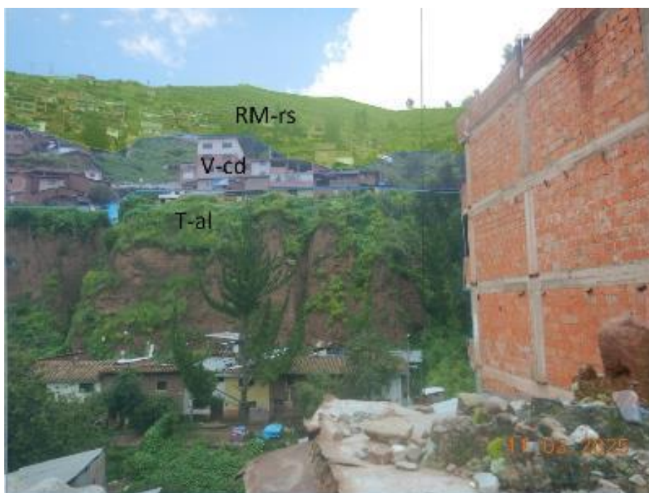
Figura 5: vertiente coluvio - deluvial, depósitos con nuevas movilizaciones pendiente a bajo
