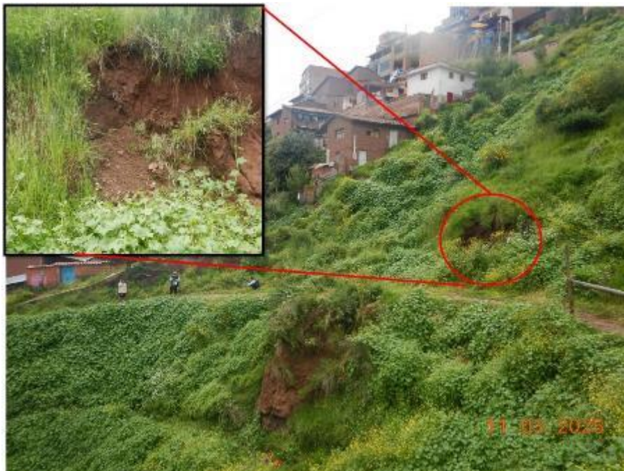
Figura 8: Por encima de la Av. J.M. Arguedas la cárcava presenta procesos de ensanchamiento lateral asociados a derrumbes en sus márgenes, cuyos materiales colapsan y se depositan hacia el canal erosivo.
