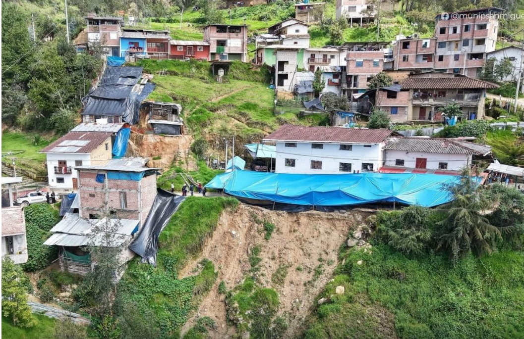
Fotografía 1. Se observa el derrumbe y las viviendas expuestas.
