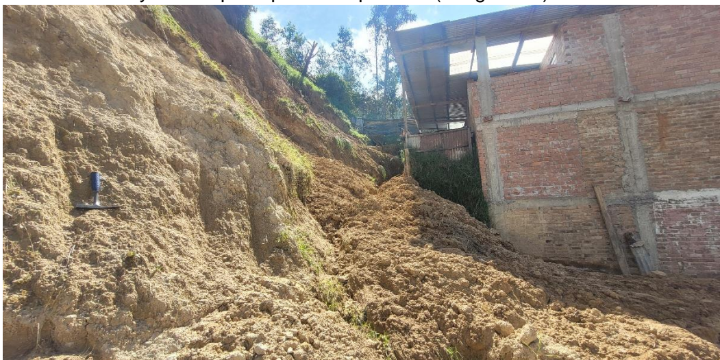
Fotografía 4. Viviendas expuestas a la zona de derrumbe (D5).
