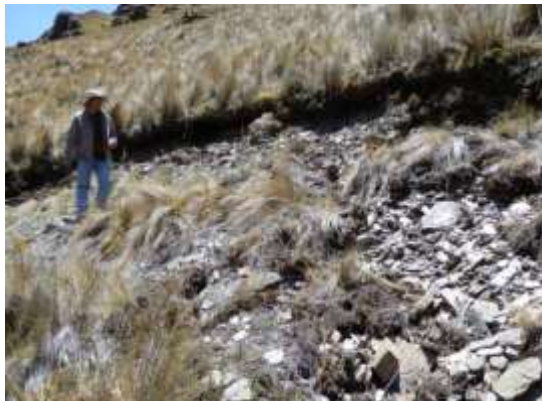
Foto 04: se observa agrietamiento en la corona del deslizamiento del cerro Caisilluni
