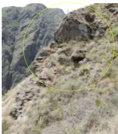
Foto 11: Vista de talud rocoso fracturado, se observa un bloque rocoso inestable
