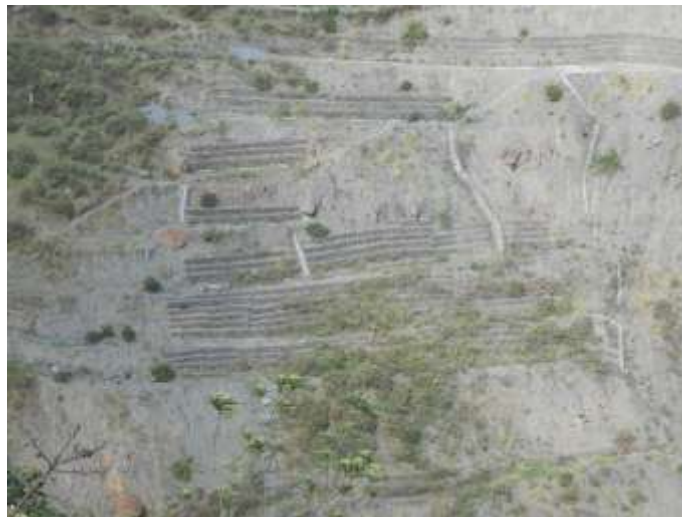
Foto 13. Muro de roca concreto con drenaje de canales revestidos.
