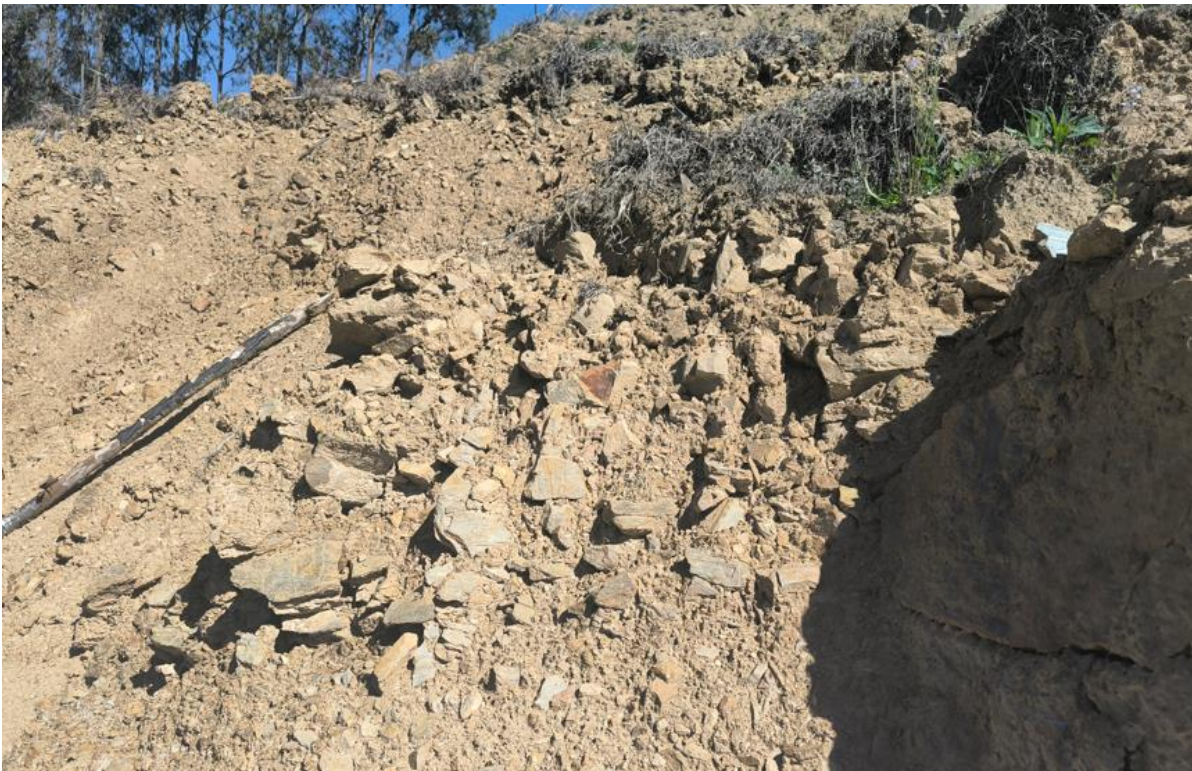
Fotografía 4. Depósitos coluviales, producto de deslizamiento reciente.
