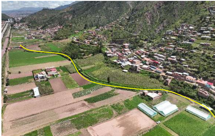
FOTOGRAFÍA 16: DEPÓSITOS ALUVIALES EN LA PARTE BAJA DE LA QUEBRADA CONDEBAMBA
