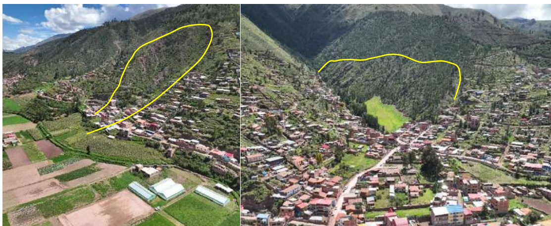
FOTOGRAFÍA 25: PROCESO DE EROSIÓN HÍDRICA EN AMBAS MÁRGENES DE LA QUEBRADA CONDEBAMBA
