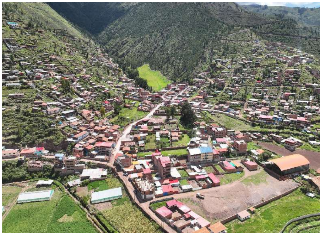
FOTOGRAFÍA 26: VISTA PANORÁMICA DE LA PARTE BAJA DEL ÁMBITO DE ESTUDIO.
