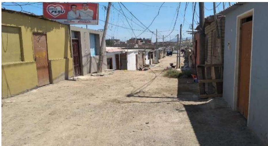
4.- Lotización y Autoconstrucción de viviendas de material liviano y noble
