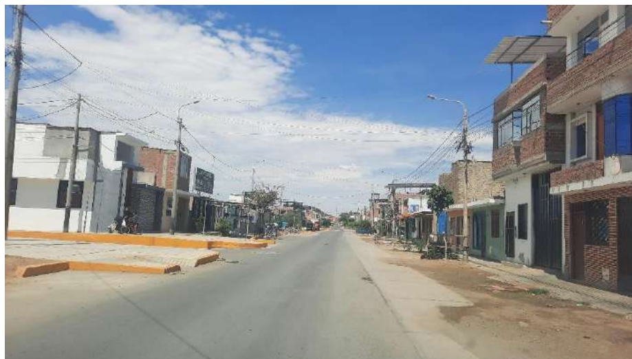
3.- Canal de regadío ha sido tapado con concreto al construirse las nuevas pistas en el AAHH
