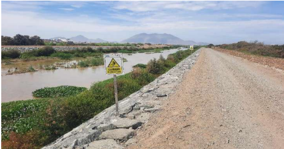
2.- Vista hacia el P.J. Villa María, se observa partes que presentan desniveles bajos respecto al enrocamiento y el río muestra que no se han realizado el descolmatación respectivo.
