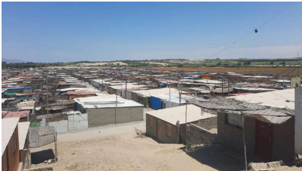
3.- Vista del AAHH, donde visualizamos las viviendas establecidas en el cauce de la quebrada san Antonio
