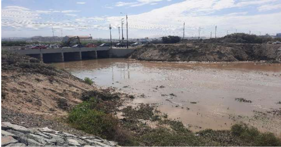
1.- Enrocado del río Lacramarca realizado por el ANIN, que falta culminar la cercanía a los puentes
