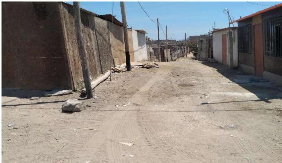
2.- Viviendas asentados en estos terrenos inestables de rellenos sin asesoramiento técnico.
