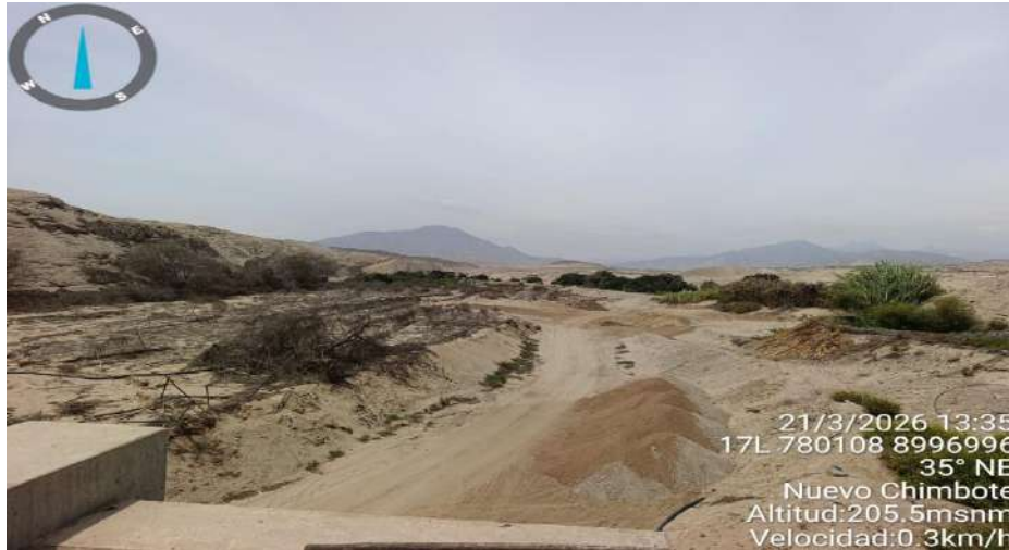
1.- Vista de la carretera que está dentro del cauce de la quebrada
