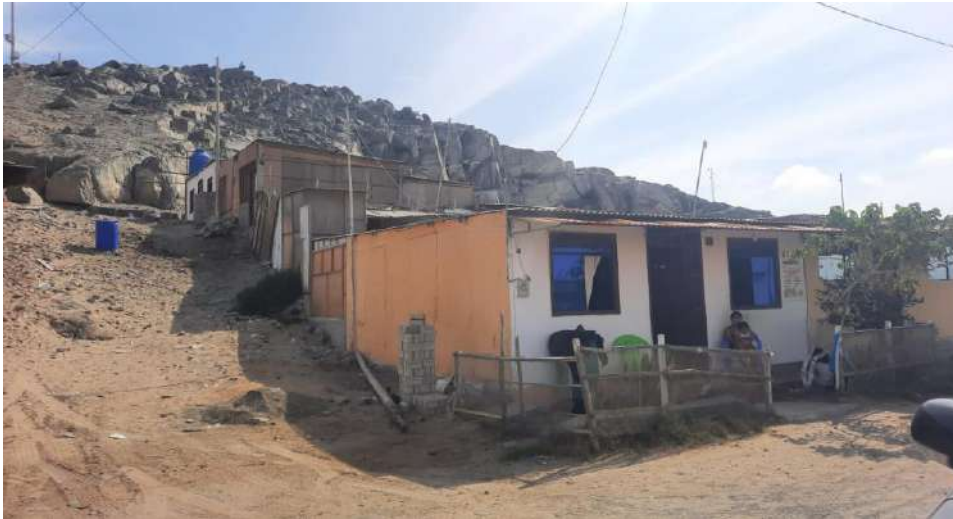
2.- Parte del AAHH colindante con cerro con material suelto y suelo duro
