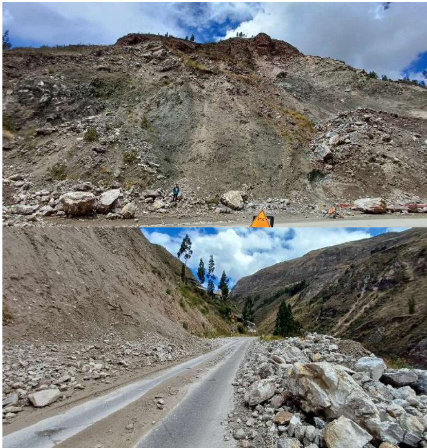
Figura 25: Caída de roca en vía Huarcondo - Urubamba
