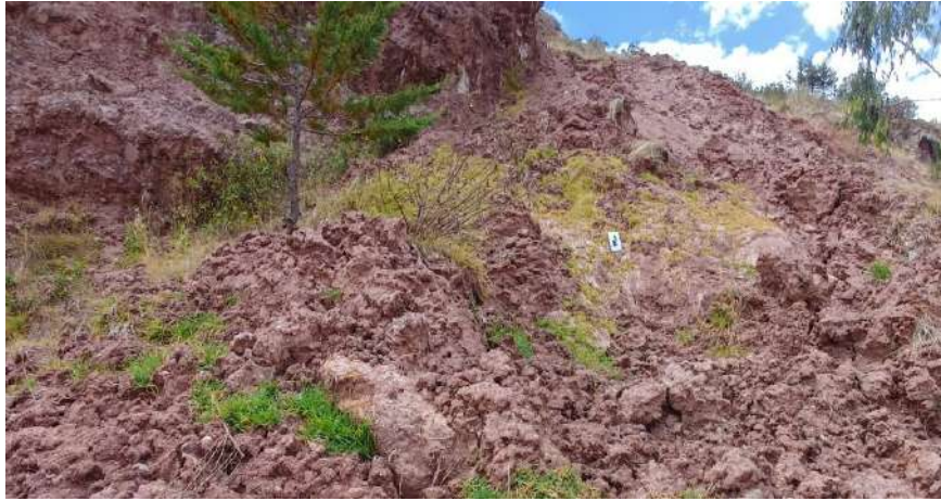
Figura 24: Derrumbe en la zona de Simaccucho - Cachimayo
