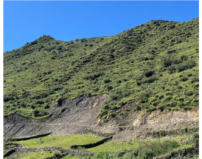
La Habilitación de nuevas vías sin asesoramiento técnico en la parte alta del CP. San Miguel de Vichaycocha pone en evidencias las condiciones de peligro de la zona de estudio.
