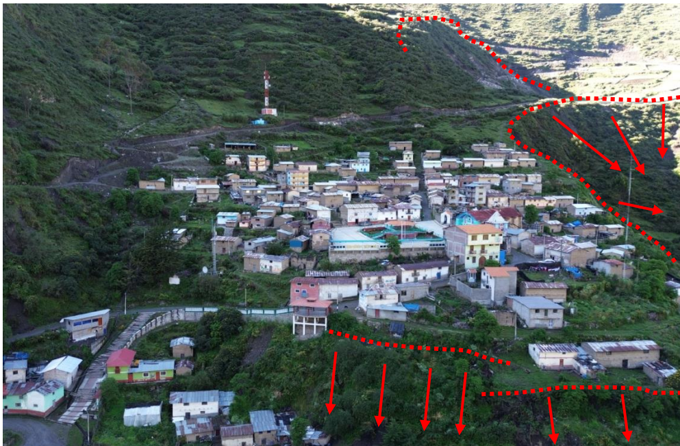
Viviendas en zonas de deslizamiento, de producirse un nuevo deslizamiento o cualquier tipo de movimiento en masa, sufrirían el derrumbe de las edificaciones ahí existentes.
