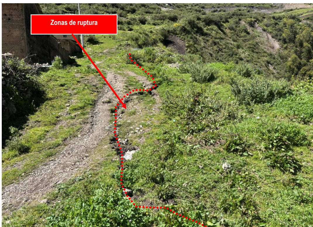
Zona de agrietamiento ubicado en la zona sur del CP san Miguel de Vichaycocha, lugar donde se han evidenciados antiguos deslizamientos. Fuente: Equipo Técnico Evaluador
