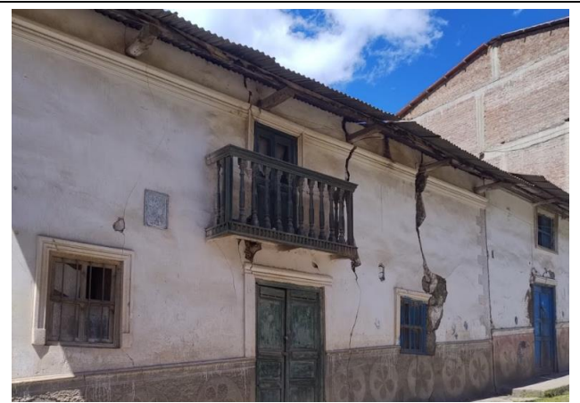
Zona de agrietamiento del suelo lo que evidencia la actividad geodinámica de la zona.
