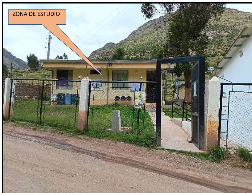
FOTO ° 01, vista panoramica del local actual de la posta de salud del Proyecto: Mejoramiento del Servicio de Atención de Salud Básicos en P.S. Oyo Oyo de Centro Poblado Santa Cruz de Oyo Oyo (Santa Cruz) Distrito de Ichuña de La Provincia de General Sánchez Cerro del Departamento de Moquegua
