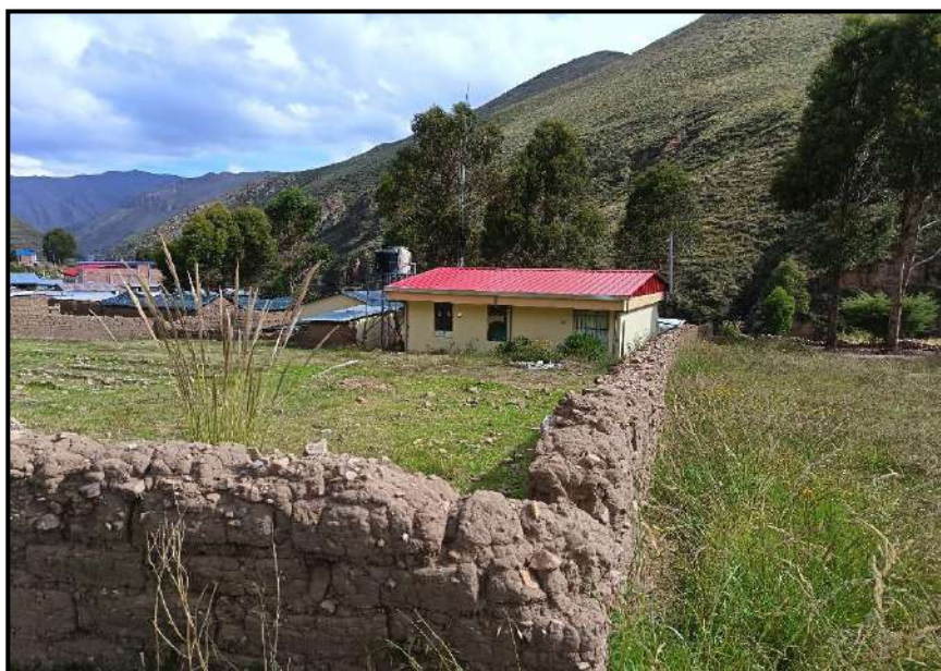
Foto 05 vista limites del primetro de la posta de salud del Proyecto: Mejoramiento del Servicio de Atención de Salud Básicos en P.S. Oyo Oyo de Centro Poblado Santa Cruz de Oyo Oyo (Santa Cruz) Distrito de Ichuña de La Provincia de General Sánchez Cerro del Departamento de Moquegua
