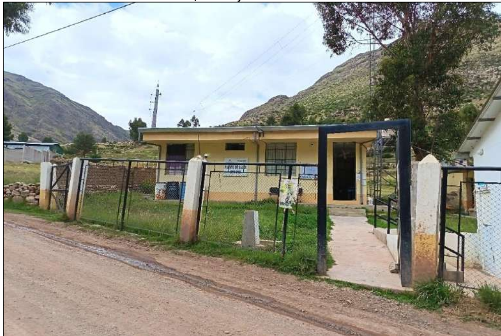
Foto N° 01; Drenaje entrada a Ichuña
