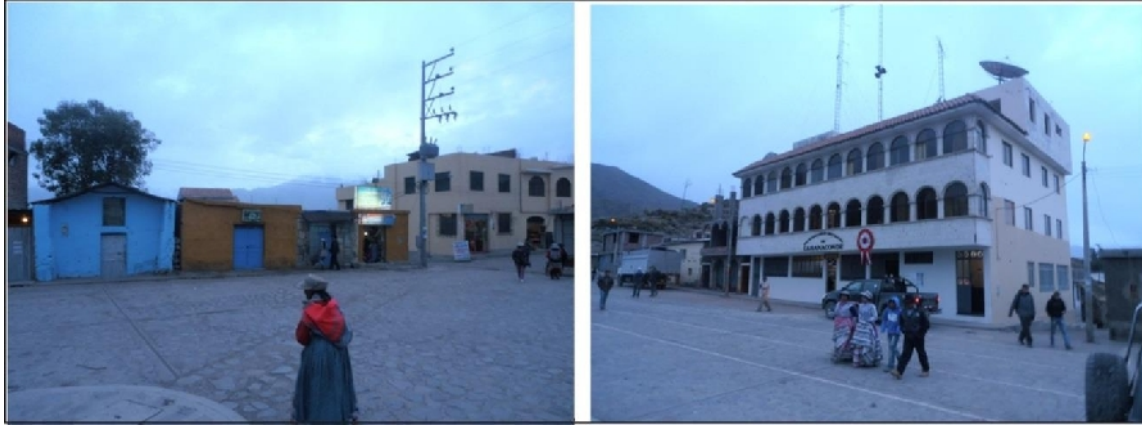
Figura 7. Viviendas de adobe, tapial y ladrillo en la plaza de armas de Cabanaconde que no fueron afectadas por el sismo de Huambo (Foto: J.C. Gomez)
