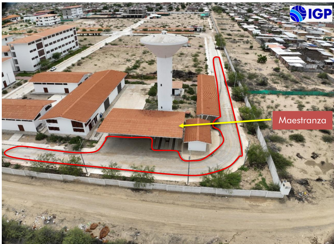
Figura 14.- Áreas inundables reconocidas durante inspección de campo en las inmediaciones del sector maestranza, cuyo origen es antrópico
