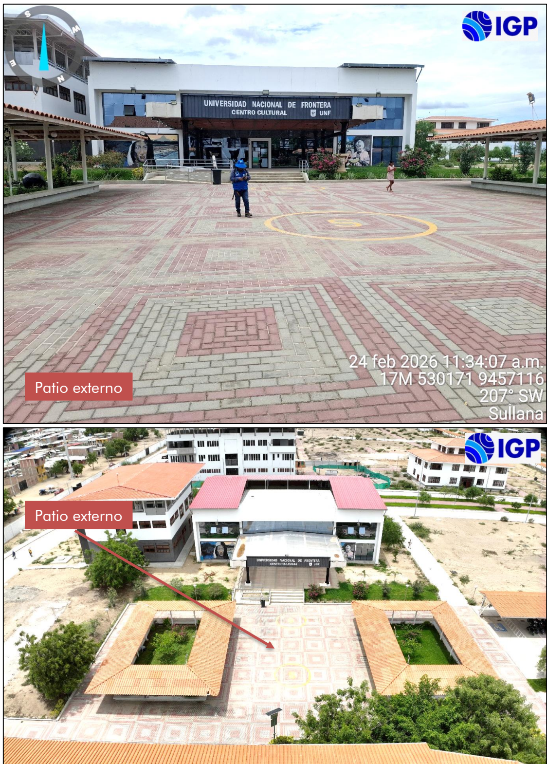
Figura 18.- Patio exterior del centro cultural expuesto a inundaciones pluviales debido a que ocupa una depresión antrópica de aproximadamente 0.50 m., de desnivel topográfico
