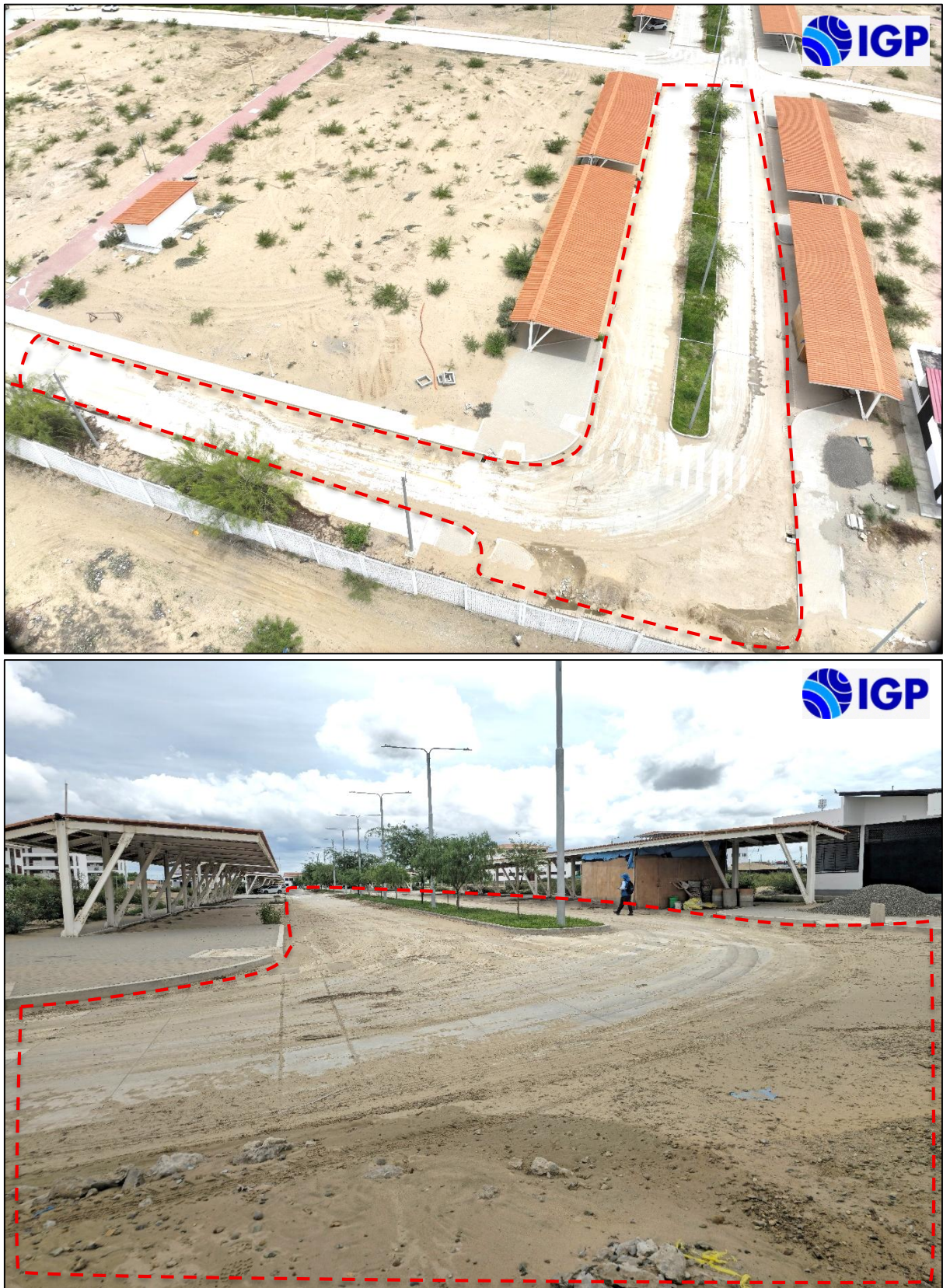
Figura 16.- Áreas inundables (polígonos rojos) identificadas en la parte posterior del campus universitario afectadas durante el mes de febrero del presente año debido a las precipitaciones pluviales y colapso de la infraestructura de drenaje
