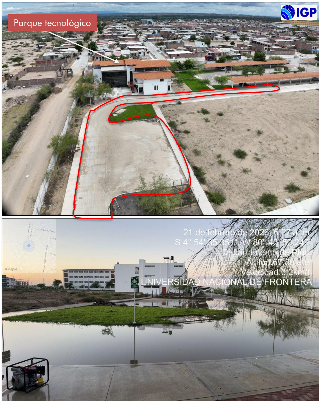
Figura 13.- Áreas afectadas por inundación pluvial delimitadas en color rojo (imagen superior) e inundaciones registradas por personal de la universidad durante el mes de febrero en las inmediaciones del Pabellón Parque Tecnológico (imagen inferior) donde emplearon motobombas para drenar el agua acumulada
