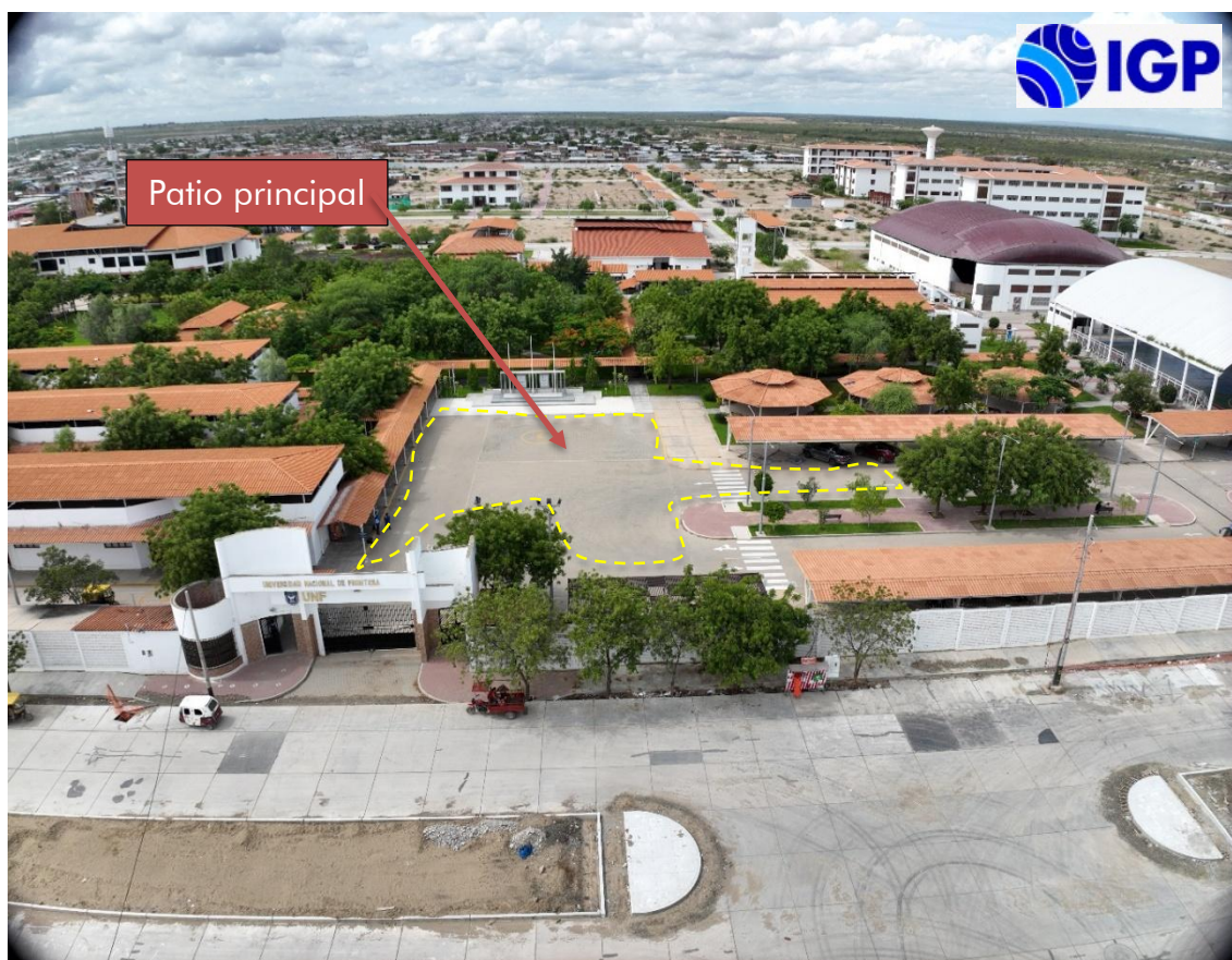
Figura 12.- Áreas afectadas (patio principal y estacionamiento) por inundación pluvial durante el mes de marzo del presente año
