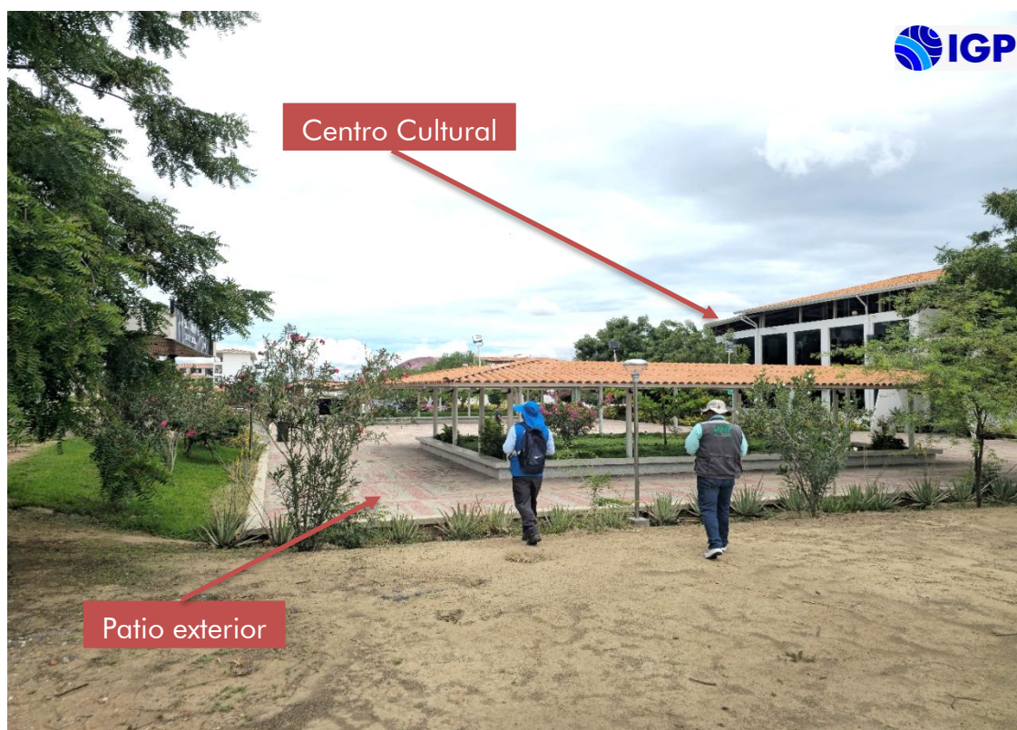
Figura 17.- Patio exterior del centro cultural con desnivel topográfico inferior de 0.50 m, expuesto a inundaciones pluviales durante los periodos de lluvia
