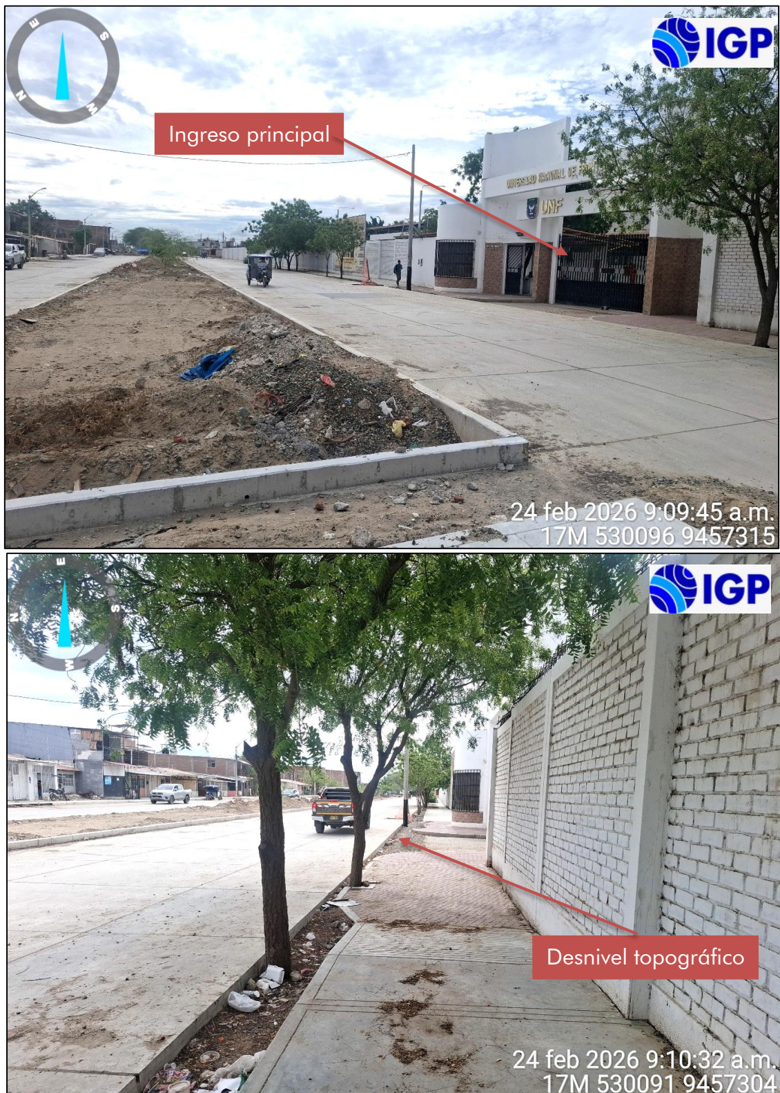
Figura 10.- En la imagen superior se observa el ingreso principal de la Universidad Nacional de Frontera desde la Av. San Hilarión. En la imagen inferior se aprecia una diferencia de nivel topográfico de aproximadamente 0.30 m entre la losa de concreto de la avenida y el acceso al campus, condición que favorece el ingreso y acumulación de escorrentías superficiales durante eventos de lluvia.
