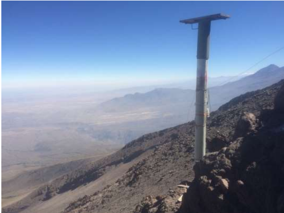
Figura 2.2. Estación Sísmica Telemétrica MST01, mástil empleado para la transmisión de datos en tiempo real.
