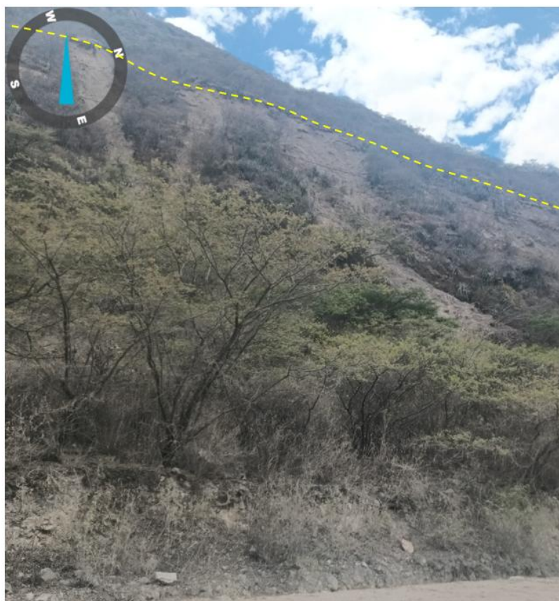
Figura 6. Deslizamiento rotacional en color amarillo.
