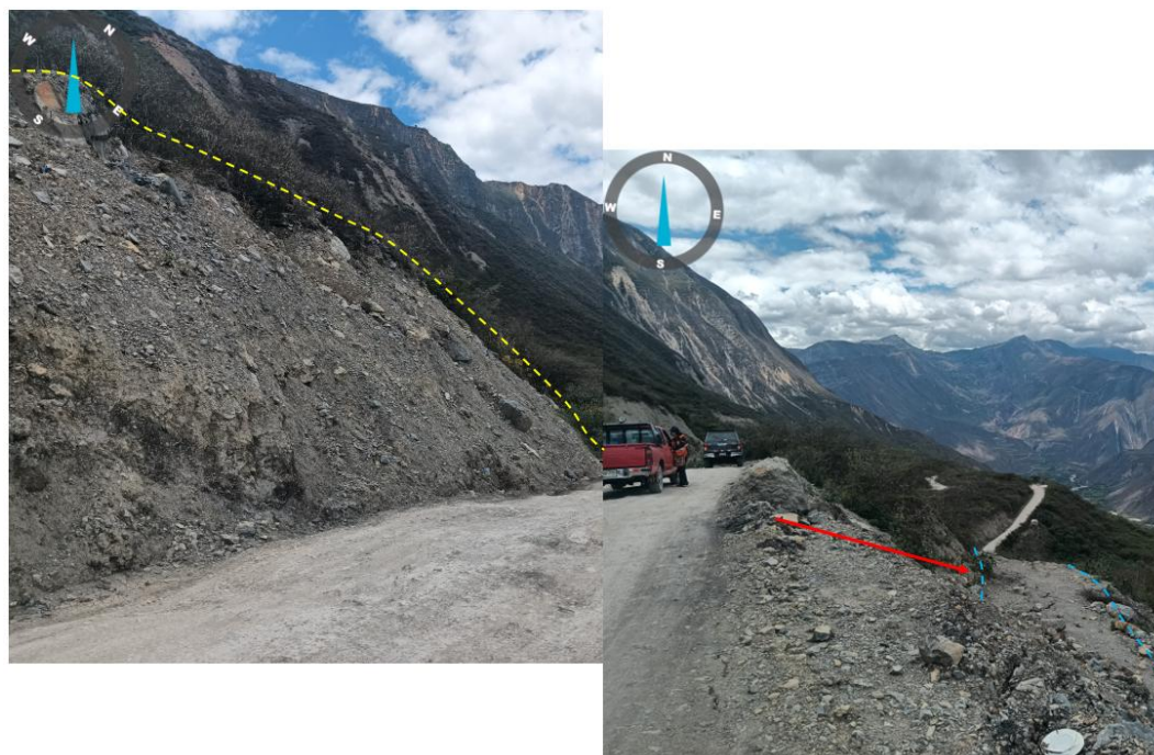
Figura 5. Deslizamiento rotacional en color amarillo, en color celeste vía CA-109 desplazada tras el deslizamiento.
