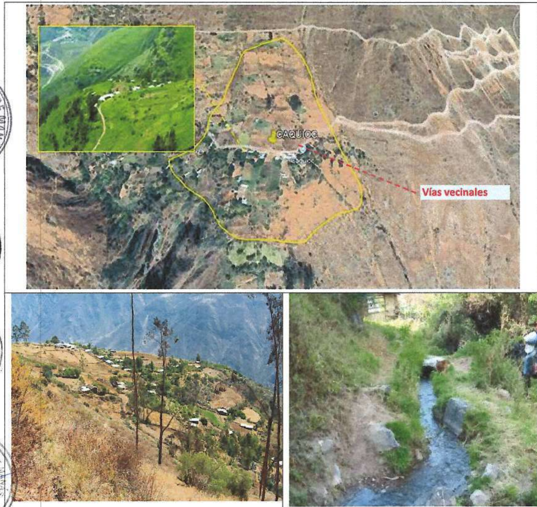
Figura N° 25. Zona crítica en el Sector Caquioc
