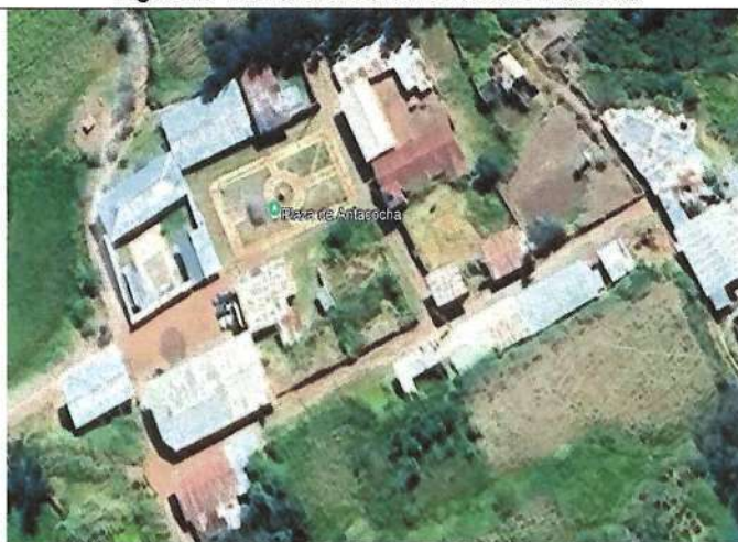
Figura N° 23. Zona crítica en el Sector Antacocha
