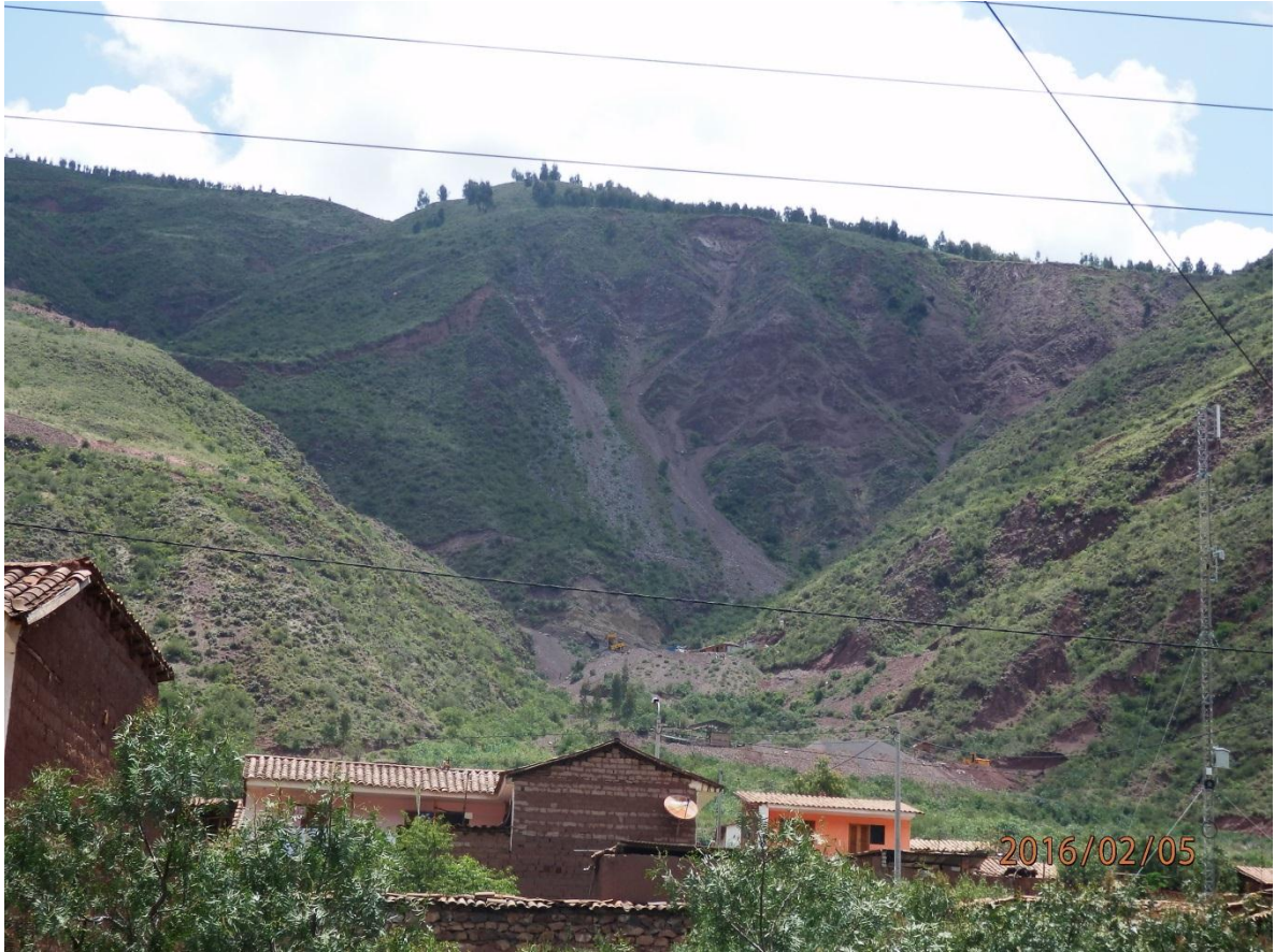
Foto 2: Vista panorámica de la quebrada Sacrahuaycco, es posible observar la zona de derrumbes y caída de rocas localizados por encima del poblado de Piñipampa.
