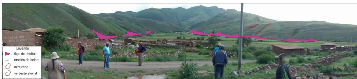
Foto 11. Vista panorámica con dirección suroeste tomada desde la zona de acogida donde se puede observar en la ladera de los cerros flujo de detritos (huaico) y otros peligros (erosión de ladera).
