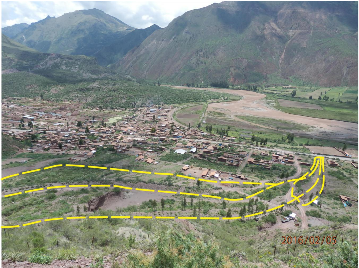
Foto 5. Vista del encausamiento y captación de escorrentía superficial, de tres canales paralelos (línea amarilla) que vierten sus aguas a un canal principal que se encuentra en la margen derecha del abanico.
