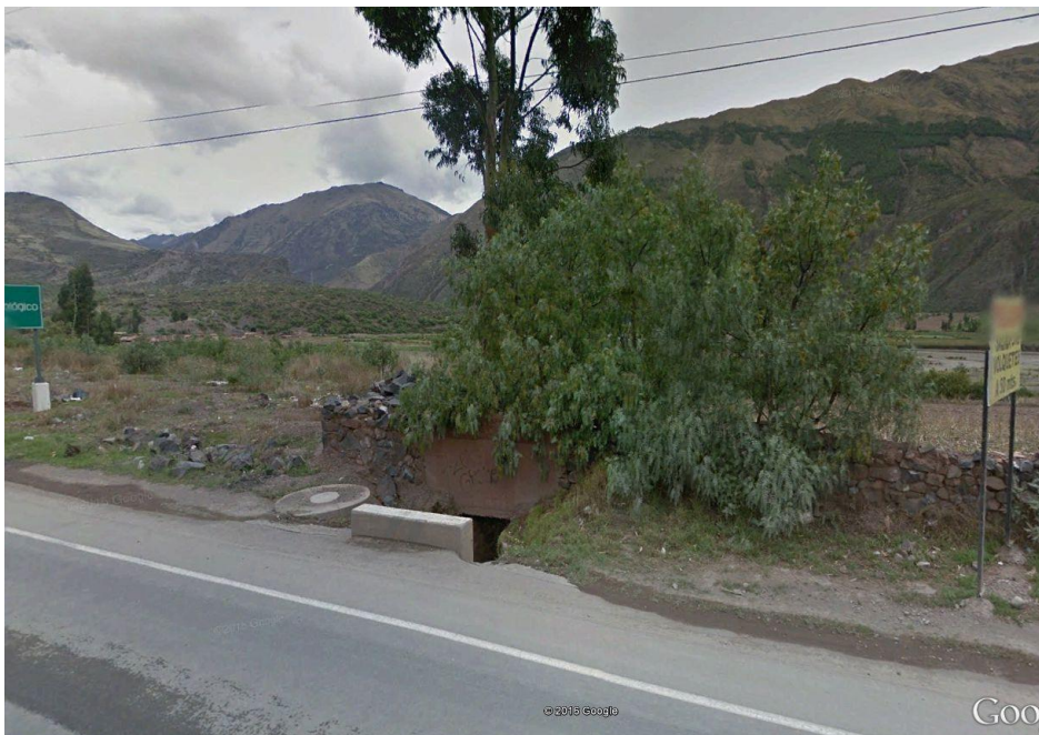
Foto 4: Vista del tramo final de la quebrada Sacrahuaycco desde la vía Cusco-Sicuani, la cual confluye en el río Vilcanota después de atravesar la vía por una alcantarilla.
