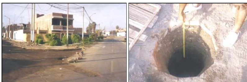
Izquierda. Se observa la Urbanización Popular de Interés Social Libertad. Derecha, se verifica en un pozo artesanal el nivel de la napa freática. Estos pozos son utilizados para el regadío de jardines, y en algunos casos para consumo.
