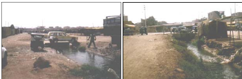
Izquierda. Canal María Angola a la altura del mercado central (uso inadecuado del canal). Derecha. Canal María Angola aguas arriba del cruce con la Av. San Leonardo. Se observa la acumulación de desechos propios de las actividades del mercado en la margen derecha del canal.
