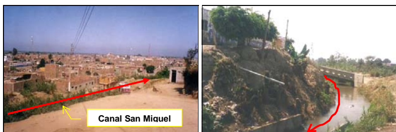
Izquierda. Canal San Miguel en la falda del cerro Candela, al fondo se observa parte de la ciudad de San Vicente. Derecha. Canal San Miguel, en la margen derecha se ubican asentamientos humanos que descargan sus desagües al canal, en la margen izquierda la contención es mediante un terraplén de tierra.
