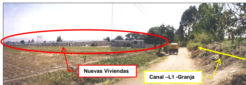
Canal L1 Granja en el tramo final de su recorrido por la ciudad de Nuevo Imperial (En la calle S/N). Se observa nuevas lotizaciones en terrenos agrícolas. El Canal L1 Granja a la derecha tiene una cota superior al de las viviendas nuevas.
