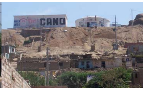
Reservorios de EMAPA Cañete, en el cerro Candela.
