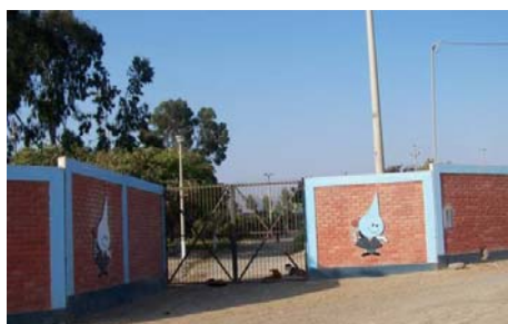
Planta de tratamiento de Alminares
