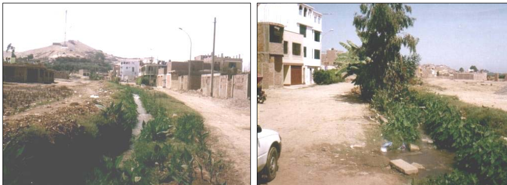
Izquierda. Canal L1 Tercer Mundo cruzando por la ciudad de San Vicente, al fondo se observa el Cerro Candela. Derecha. Canal L1 Tercer Mundo, se observa el canal expuesto y con huella de rebose en la calle.
