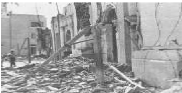
Terremoto de 1950, que afectó la misma zona que el del 2007. Fotos: Almanaque Estadístico. INEI
