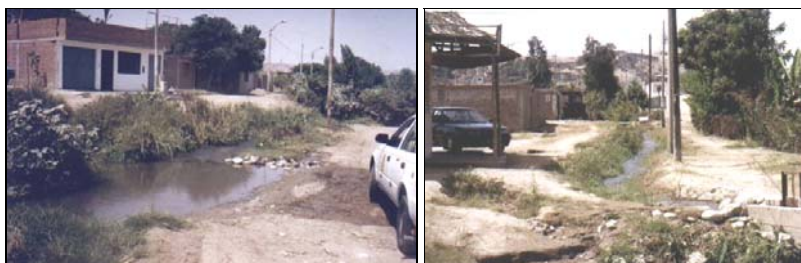
Izquierda. Canal L1 Granja en la Calle Almenares – Nuevo Imperial. Derecha. Canal L1 Granja en el Jr. Miguel Aljovín, próximo al cruce con el Canal Viejo Imperial – Nuevo Imperial.
