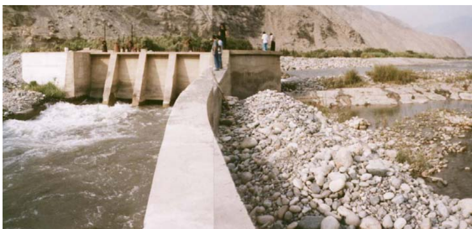
Se observa la bocatoma Imperial sobre el río Cañete.
