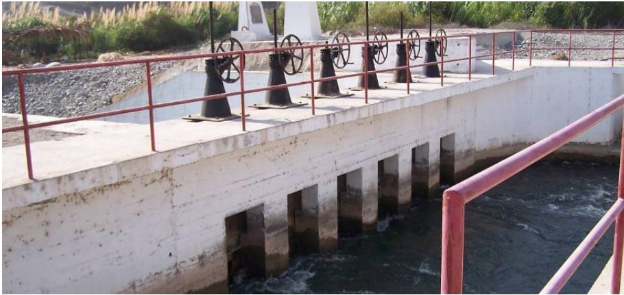
Bocatoma cerca del puente Socsi
