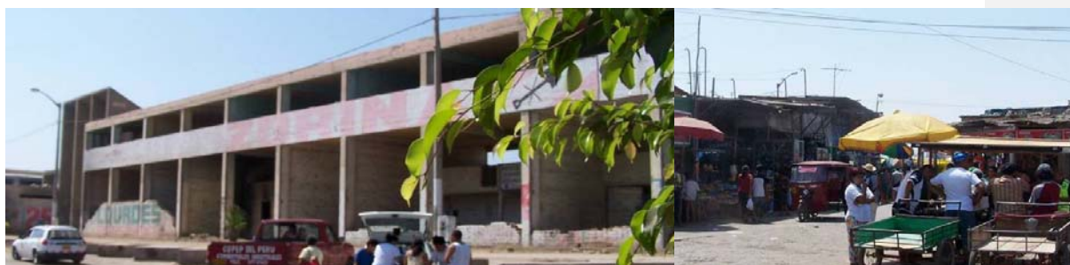
Mercedo Modelo, destruído, y Mercado provisional del Jr. Santa Rosa. San Vicente de Cañete.
