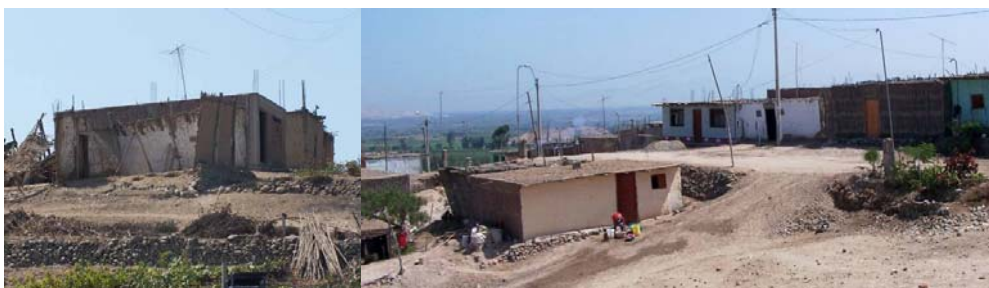
Viviendas de adobe y quincha, en Nuevo Imperial.
