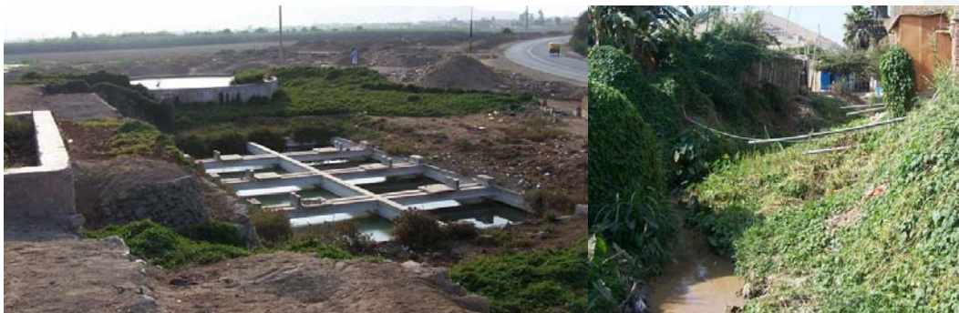
Planta de tratamiento de aguas servidas. Nuevo Imperial.
