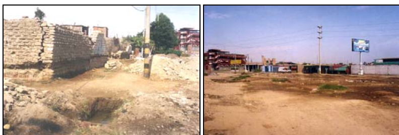
Izquierda. La Asociación de Vivienda Villarreal se observa el suelo húmedo, en la calicata el nivel freático a 0.60 m de la superficie. Derecha, Urb. Huerto San Leonardo al frente de la Assoc. De Vivienda Villarreal, se observa el suelo húmedo.
