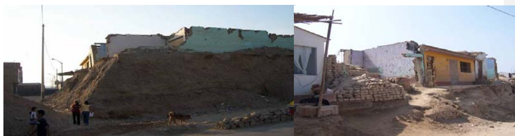
Calle 15 de Noviembre. Viviendas construidas sobre una elevación en la zona urbana de Imperial.
