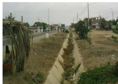
En las fotografías se observan dren y canaletas que corren el riesgo de quedar inoperativas debido a que no tienen el debido mantenimiento
