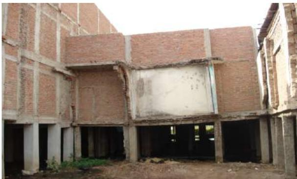
En la vista se observan viviendas que han sido declaradas inhabitables pues fueron construidas en el lecho de la quebrada Bramador y la otra causa es que al no haber cumplido las normas de construcción han colapsado ante la ocurrencia de fenómenos naturales (precipitaciones pluviales e inundaciones)
