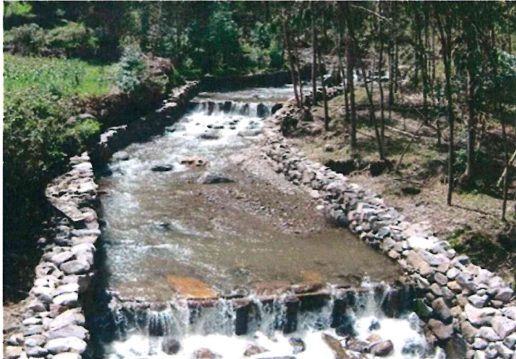
Imagen 18: Disipadores de Energía
