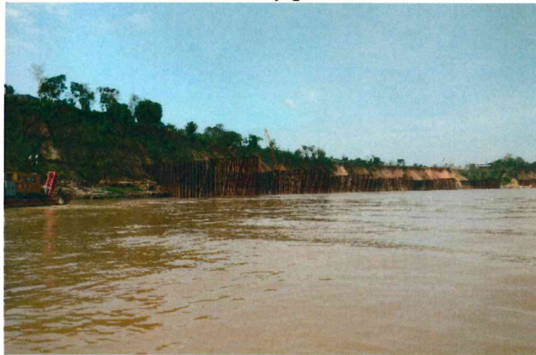
Imagen N° 16: Protección con espigones de acero
