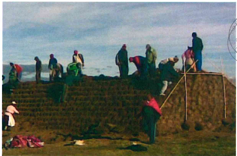
Imagen N° 17: Dique de bloques vegetativo
