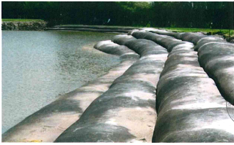
Imagen N° 11: Protección con geotubos
