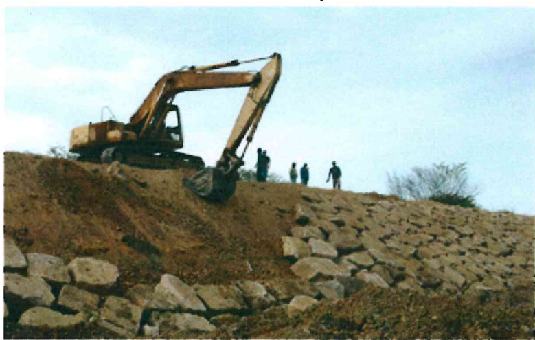
Imagen 10: Conformación de dique enrocado
