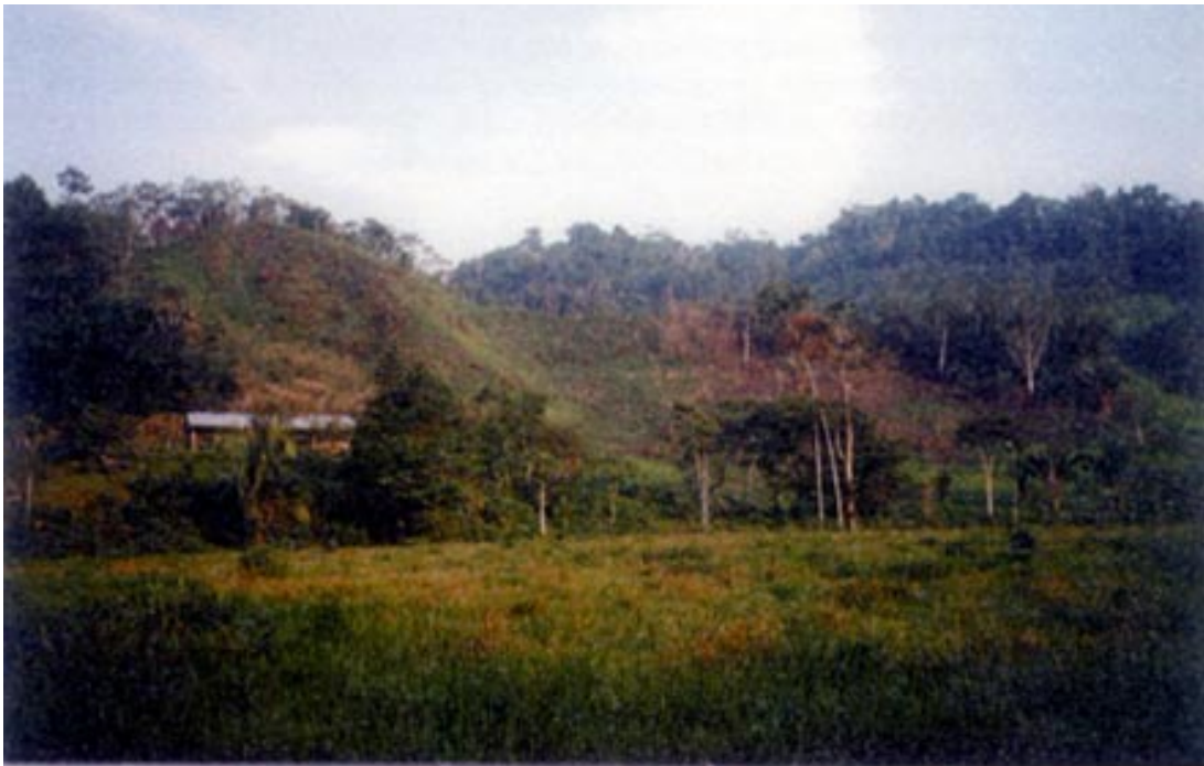
Foto N°3.4 Lomas altas desarrolladas en la Formación Sarayaquillo, margen derecha del río Huaquisha (hoja de Uchiza).
