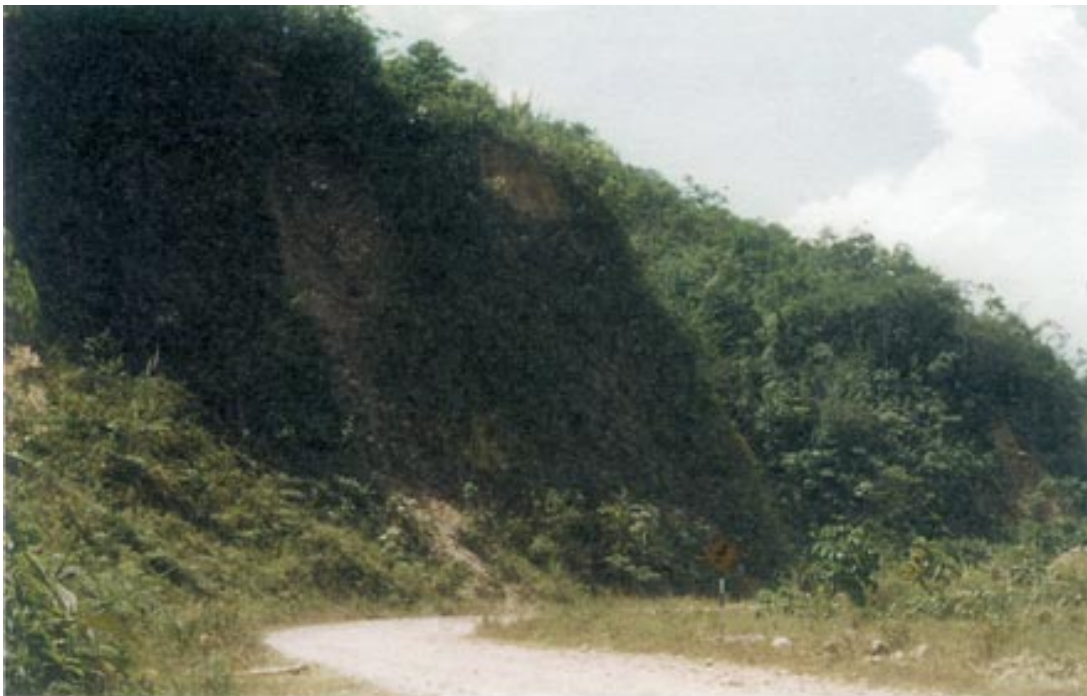
Foto N°9.4 Corte en la carretera marginal, mostrando paredes verticales en conglomerados inconsolidados. Carretera de Tocache a Pizana.
