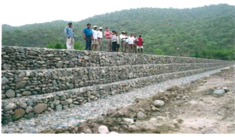
Imagen N° 13: Protección con gaviones
