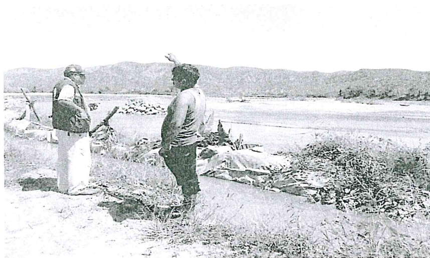
FOTOGRAFIA MUESTRA LA EROSION DE LAS PARCELAS AGRICOLAS EN LA MARGEN DERECHA DEL RIO UTCUBAMBA, DONDE SE ESTA PROPONIENDO CONSTRUIR 08 ESPIGONES PARA EL DIRECCIONAMIENTO DEL FLUJO DEL AGUA.
