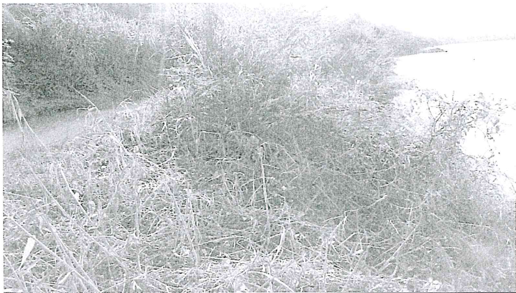
FOTOGRAFIA MUESTRA LA CERCANIA EN LA MARGEN DERECHA DEL RIO UTCUBAMBA EN EL TRAMO DONDE SE UBICA EL CANAL HUARANGOPAMPA
