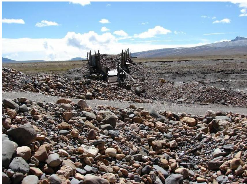
Foto N° 19: Vista del estribo derecho de la Presa B1, obsérvese el “chute” de grandes dimensiones.
