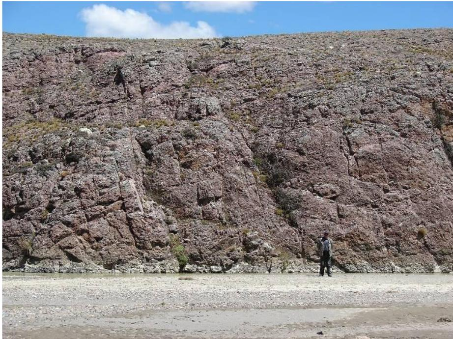
**Foto N° 30: Presa B3, estribo izquierdo. Obsérvese el intenso fracturamiento de la roca**
