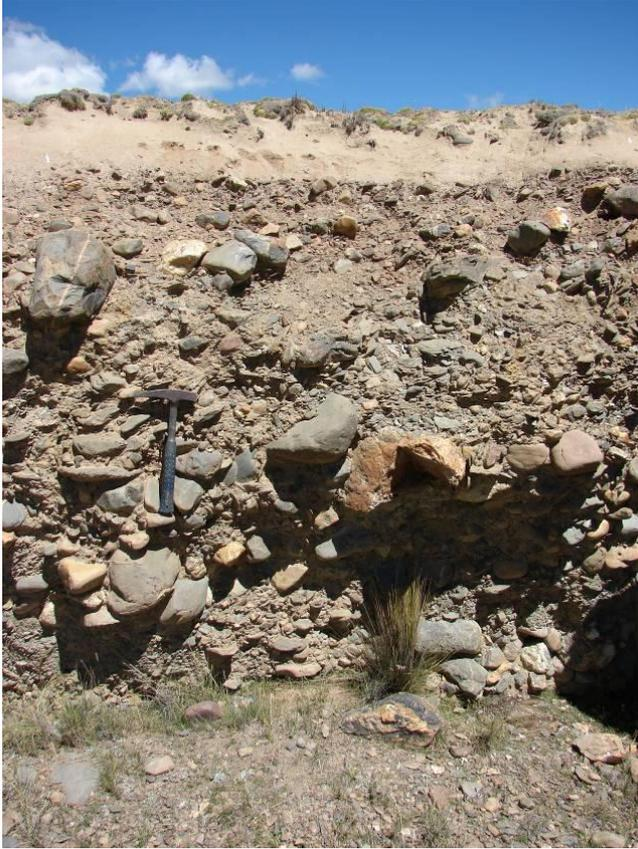
Foto N° 18: Detalle del material donde se asentará el estribo derecho de la Presa B1. Gravas GW-GM
