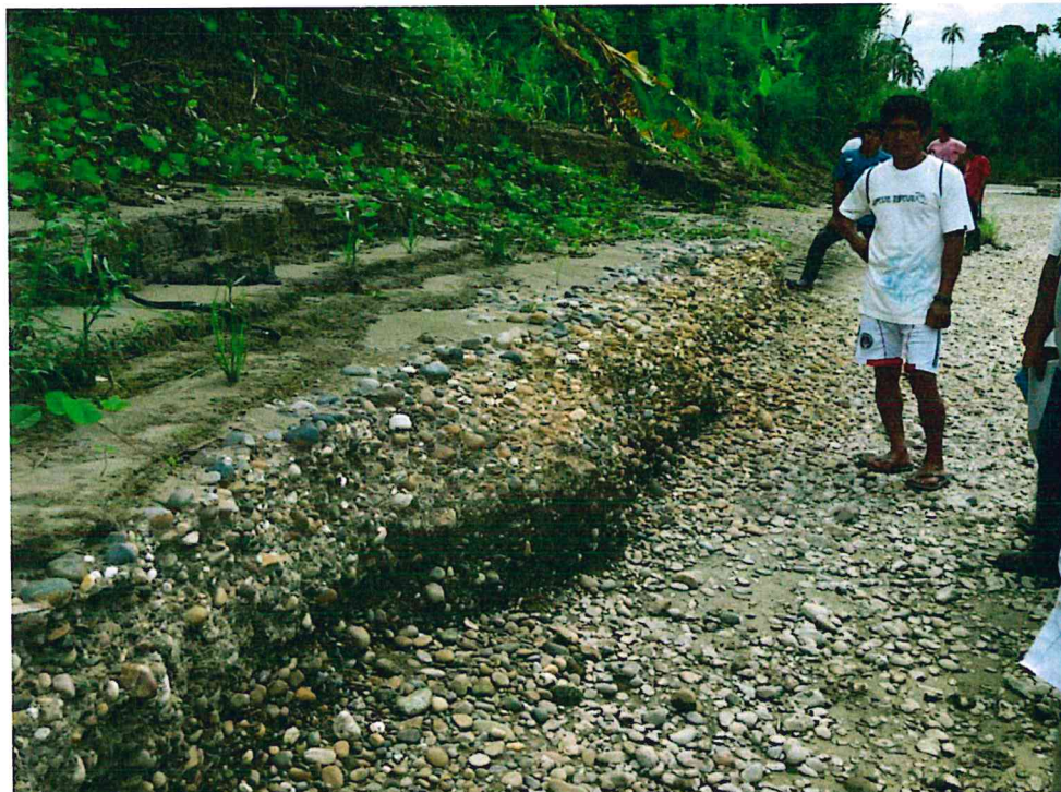
Foto 3 Vista tomada a la margen izquierda del río Marañón aguas arriba del poblado de Tampe, se observa depósito aluvial 2 , constituido de clastos heterométricos subredondeados a redondeados con matriz areno limosa inconsolidada.
