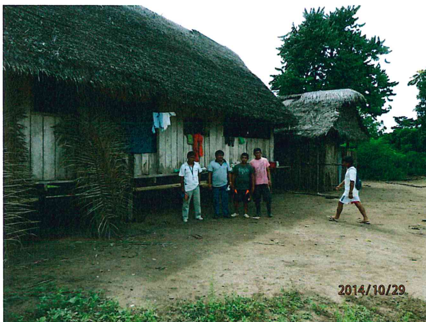
Foto 14. Vista de vivienda diseñada para periodos de inundación
