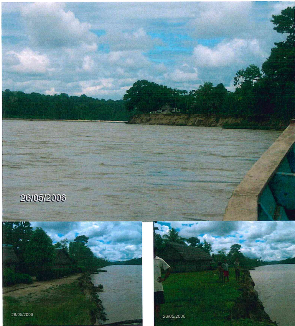
Foto 5, 6 y 7 Imágenes tomadas en el año 2006 donde se observa viviendas que se encuentra en la margen izquierda del río Marañón, que es afectada por la erosión fluvial.
