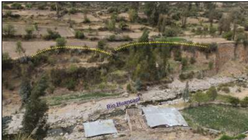
Foto 11. Deslizamientos frente al complejo deportivo Maracaná.
