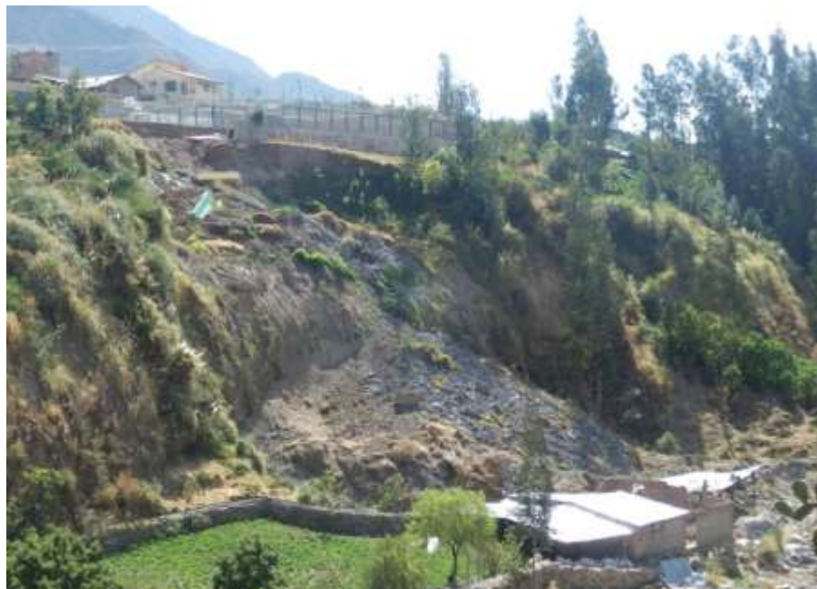
Foto 2. Deslizamiento en el sector adyacente al complejo deportivo Maracaná.
