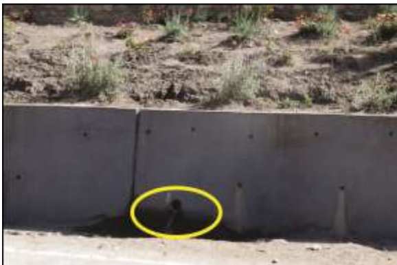
Fotos 9 y 10. Filtraciones de agua, que no tienen canalización.
