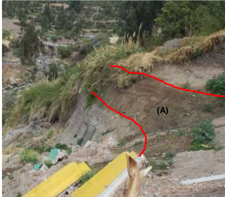
Foto 5. Se aprecia humedecimiento de la escarpa del deslizamiento (A).
