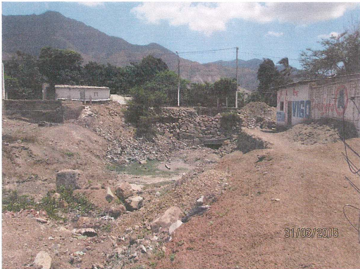
FOTOGRAFÍA N° 06: ALCANTARILLA DE DESFOGUE DE LA QUEBRADA LOS CASTROS COLMATADA CON SEDIMENTOS.
