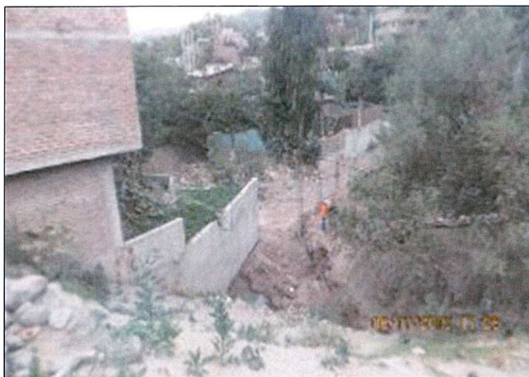
Figura 20. Barrio Cuchipampa, asentado en la quebrada Quinuapata
