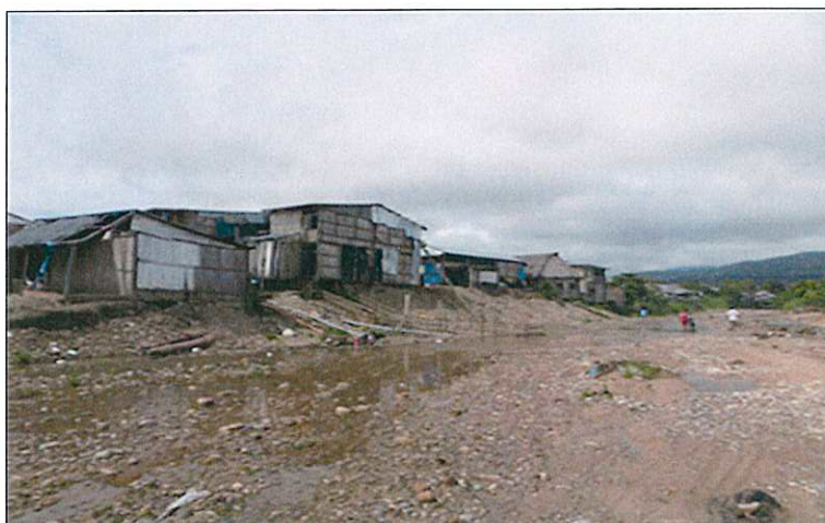
Figura 15. Localidad Atalaya, asentado en la quebrada Campo Plata
